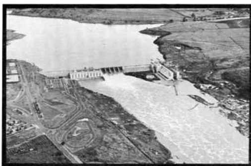
Barra Bonita, no Rio Tietê (140MW)
