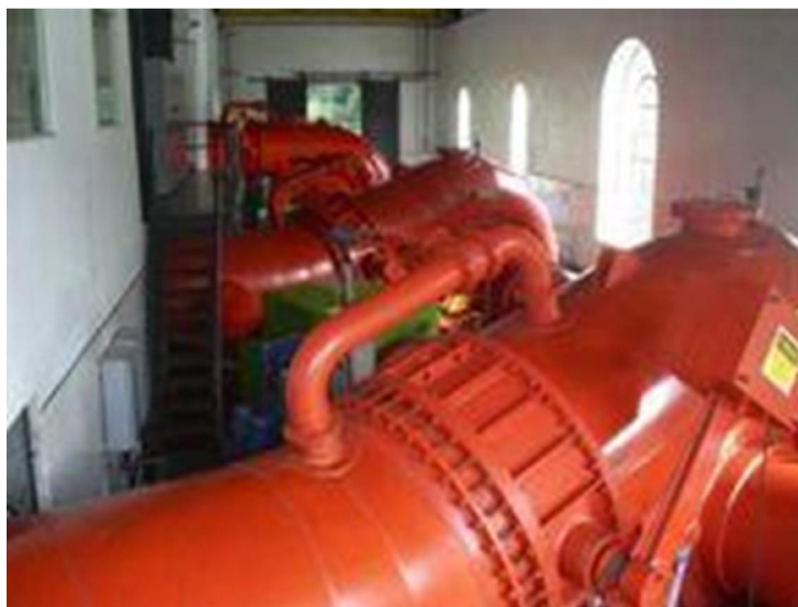
Figura 25 - Vista geral das Turbinas Hidráulicas (Foto do Autor)
