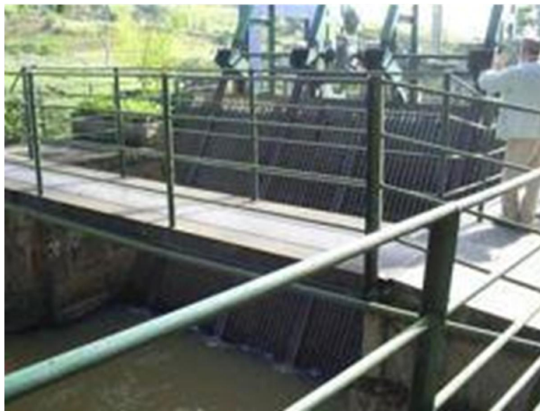
Figura 18 - Início da Tomada d'água, com a grade de limpeza (Foto do autor)
