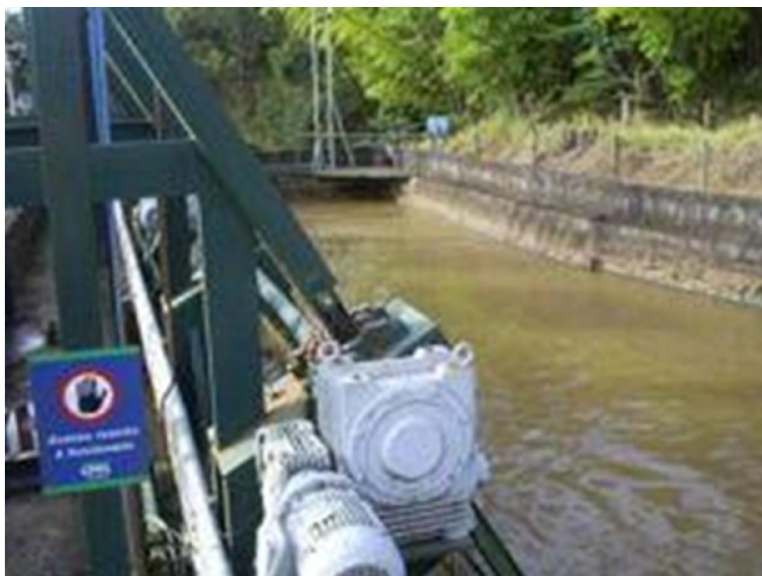
Figura 20 - Final do canal de adução e comporta da Câmara de Carga (Foto autor)
