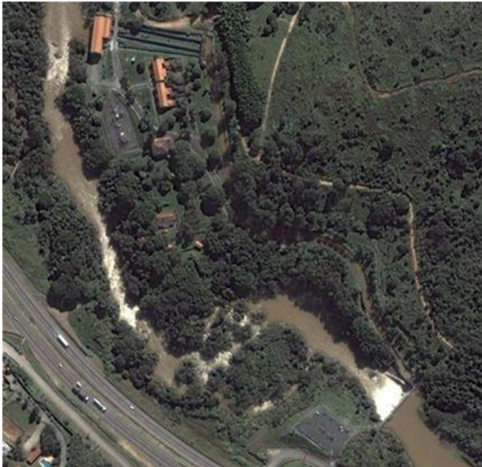
Figura 6 - Fotografia de Satélite da PCH Salto Grande, onde a água é levada pelo canal de adução (pressão baixa) até os condutos forçados (pressão alta) e depois à casa de força (Fonte: Google)
