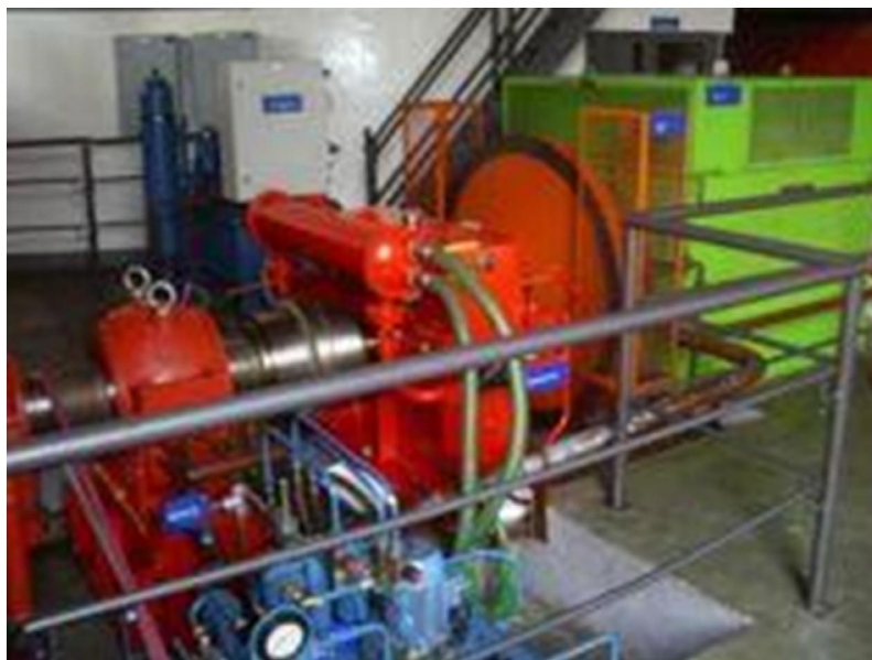
Figura 26 - Da direita para a esquerda: Gerador, Volante de Inercia, Multiplicador, Mancal e Unidade de Lubrificação (Foto do autor)
