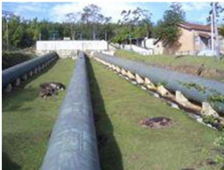
Figura 22 - Conduitos Forçados (Foto do autor)
