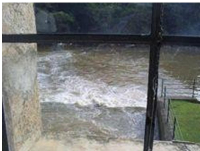
Figura 27 - Saída do Canal de Fuga (Foto do autor)
