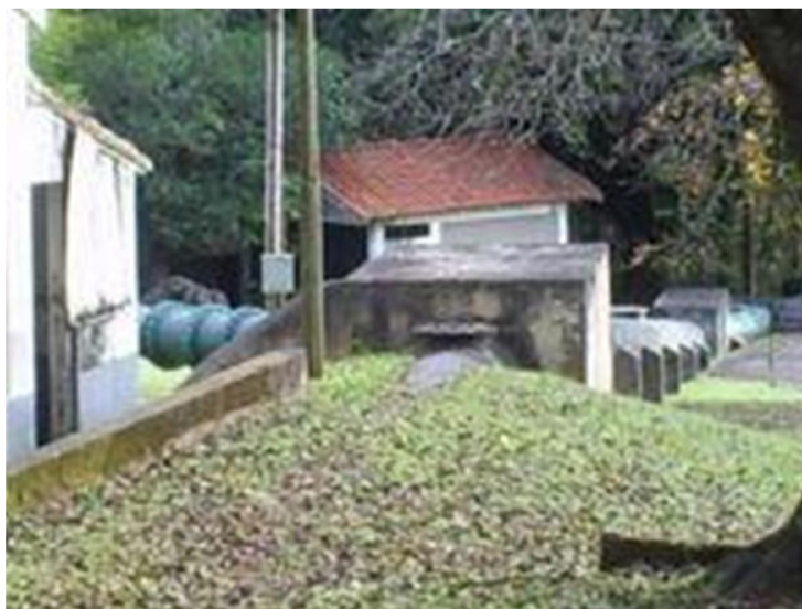
Figura 29 - Micro Usinas Hidrelétricas (Foto do autor)
