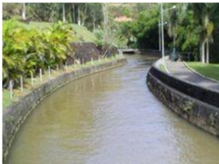
Figura 19 - Canal de Adução (Foto do autor)
