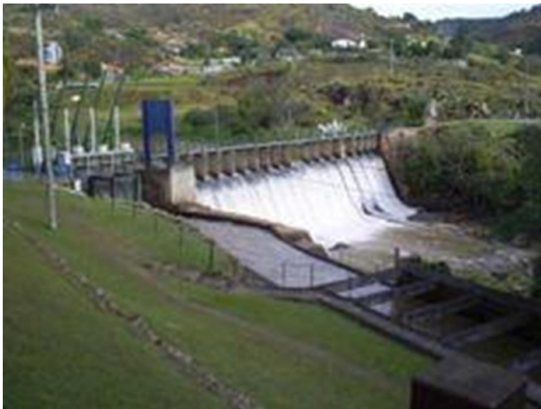
Figura 14 - Barragem vista da margem leste do Rio Atibaia (Foto do autor)
