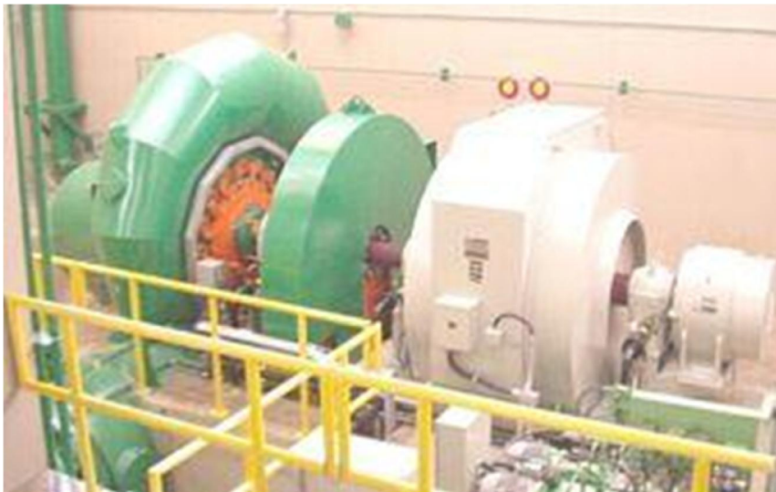
Figura 8 - Turbina, Gerador Síncrono, Volante de Inércia e Excitatriz de uma PCH
