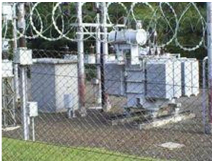
Figura 28 - Subestação Elevadora (Foto do autor)
