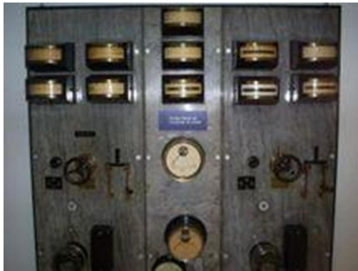
Figura 24 - Antigo Painel de Controle da Usina (Foto do Autor)
