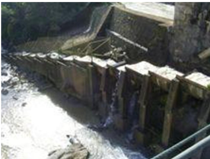
Figura 17 - Escada para peixes (Foto do autor)
