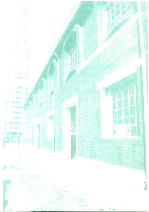
Fachada posterior, antes e depois da restauração: as mutilações da fachada foram retiradas, recuperando-se os vãos de janelas e portas e a alvenaria de tijolo laminado.
