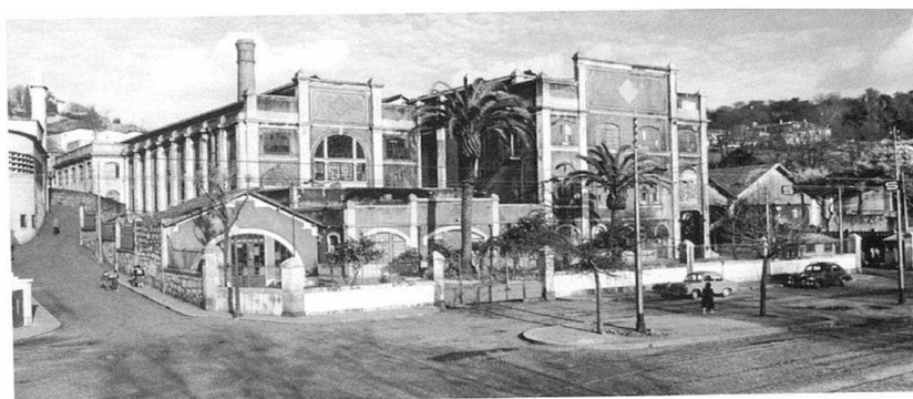
Figura 73. Central Térmica de Massarelos, Porto, Portugal. Fonte: MATOS, 2003
