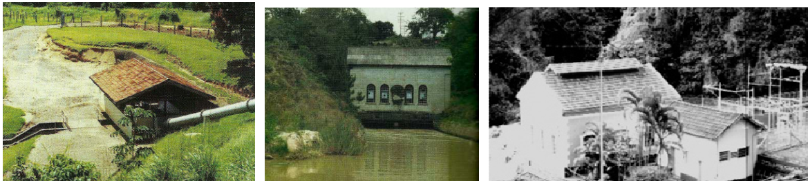
Figura 125. Fig. 125A. UHE Ribeirão do Pinhal; Limeira. Fig. 125B. UHE Pilar; Pilar do Sul. Fonte: Amaral e Prado (2000). Fig 125C. UHE Monjolinho II; São Carlos. Foto do autor, 2002
