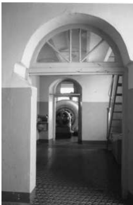
Figura 85. Sala de máquinas da UHE Capão Preto, São Carlos, SP. Foto do autor, 2002
