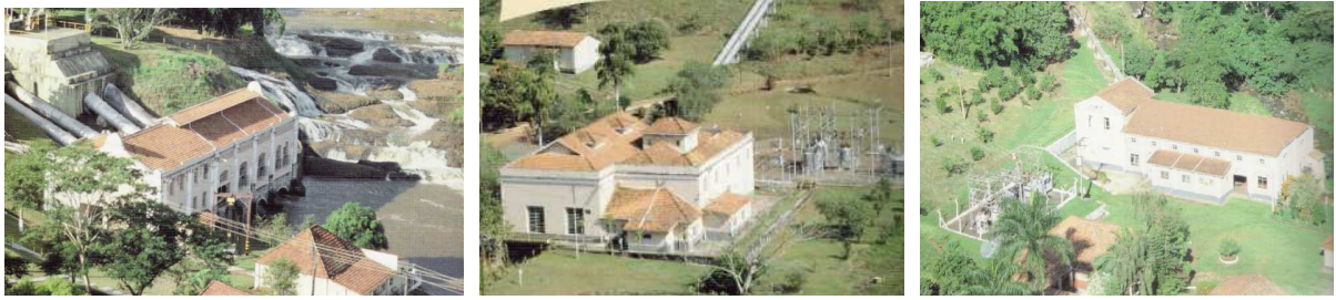
Figura 119. Fig. 119A. UHE Gavião Peixoto, Gavião Peixoto. Fig. 119B. UHE Capão Preto; São Carlos. Fig. 119C. UHE do Chibarro; Araraquara. Fonte: Amaral e Prado (2000).
