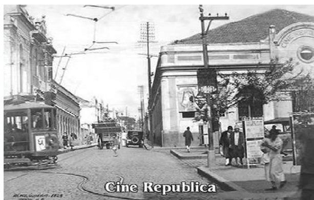
Figura 19. Avenida Francisco Glicério e bonde da Campineira vindo pela Rua da Conceição, provavelmente em 1929, Campinas. Fonte: Getulio Grigoletto (2009)
