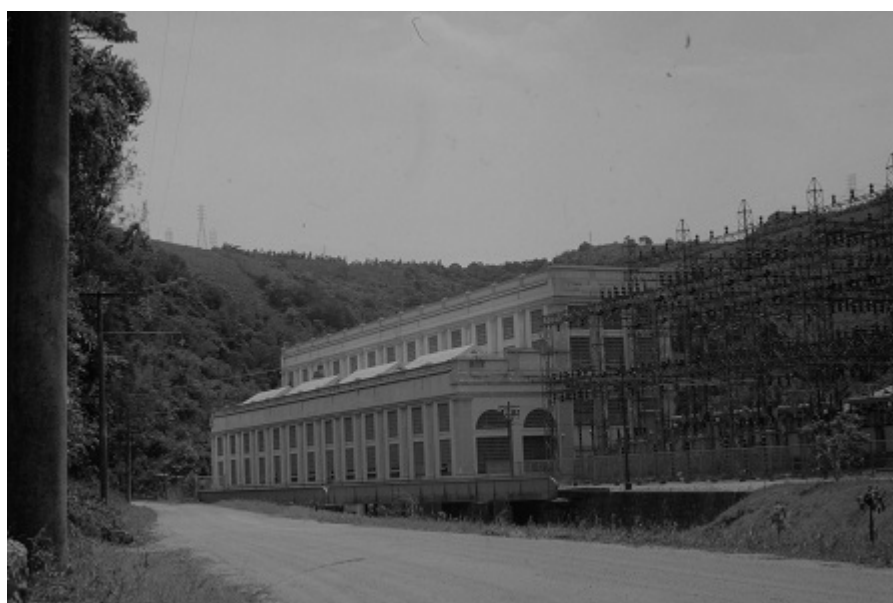
Figura 83. Vista da usina Ituparanga em Votorantim. Fonte: Toninho Gavioli
