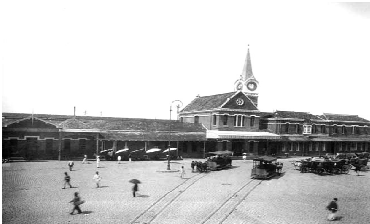
Figura 39. Estação da Estrada de ferro de Campinas em 1878. Notar os postes da cidade já eletrificada e os bondes puxados por cavalos. Fonte: Getulio Grigoletto, 2009
