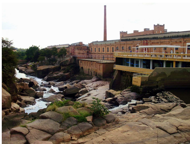
Figura 76. Vista do complexo Brasital. Fonte: Google images (2010)
