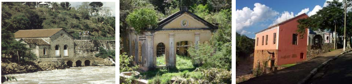
Figura 124. Fig. 124A. UHE Salto, Salto. Fig.124B. Ruínas da UHE Quilombo; Jundiaí. Fig. 124C. Museu da Água UHE Luís de Queirós; Piracicaba. A UHE deveria ter o mesmo prédio, sendo edificações idênticas e complementares. Fonte: www.semaepiracicaba.org.br
