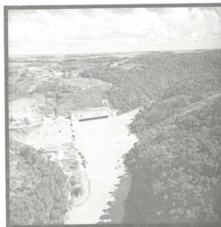
Jacuí, usina de porte médio da CEEE.
