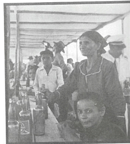
A gente sofrida do "Polígono das Secas" ergueu com seu trabalho uma grande esperança em concreto. Na época, Paulo Afonso I foi saudada como a "redenção do Nordeste".
