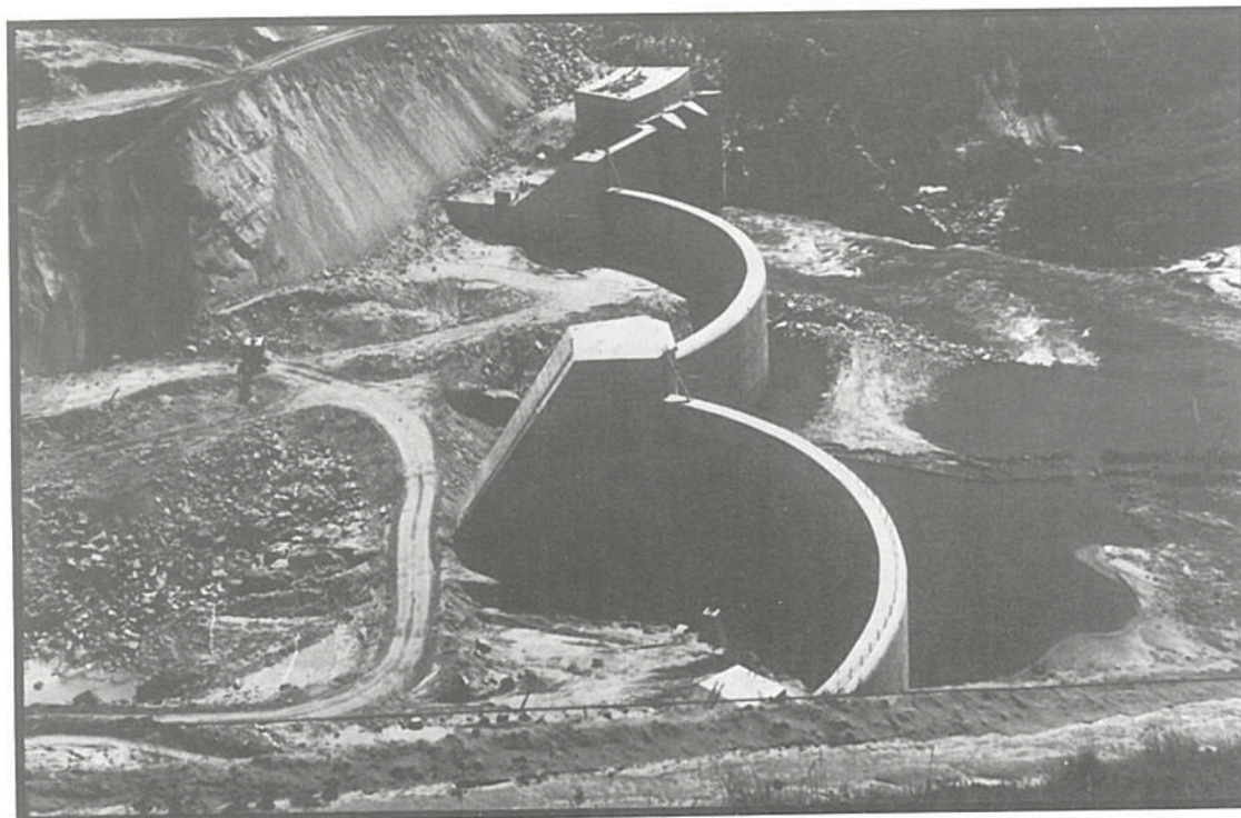
Em 1967, Furnas assumiu o término da construção da hidrelétrica de Funil, cuja barragem de abóbada de concreto tinha por dimensões 385 m de extensão e 85 m de altura e consumiu 480.000 m 3 de concreto. Situa-se no rio Paraíba, município de Rezende, RJ.
