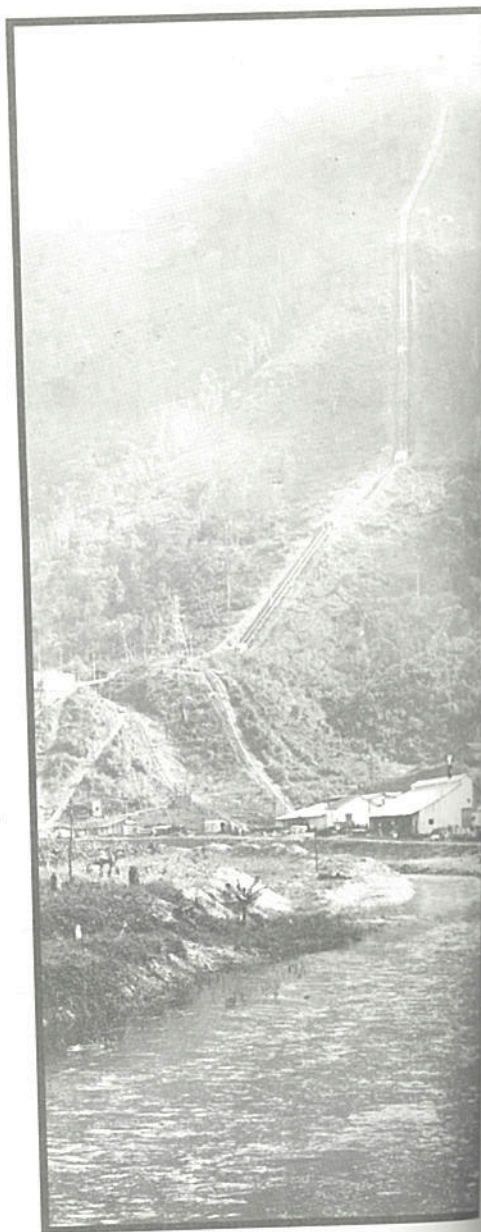
A usina de Cubatão (atual Henry Borden), na raiz da Serra, é alimentada pelas águas do rio das Pedras. Entrou em funcionamento com a máquina nº 1 em 1926, gerando uma potência total de 28.000 kW.
