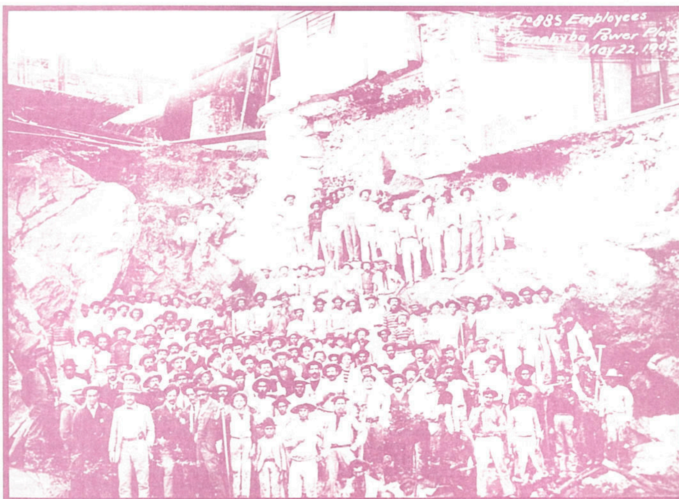
Operários empregados na construção da Usina de Parnaíba, 22/5/1907
