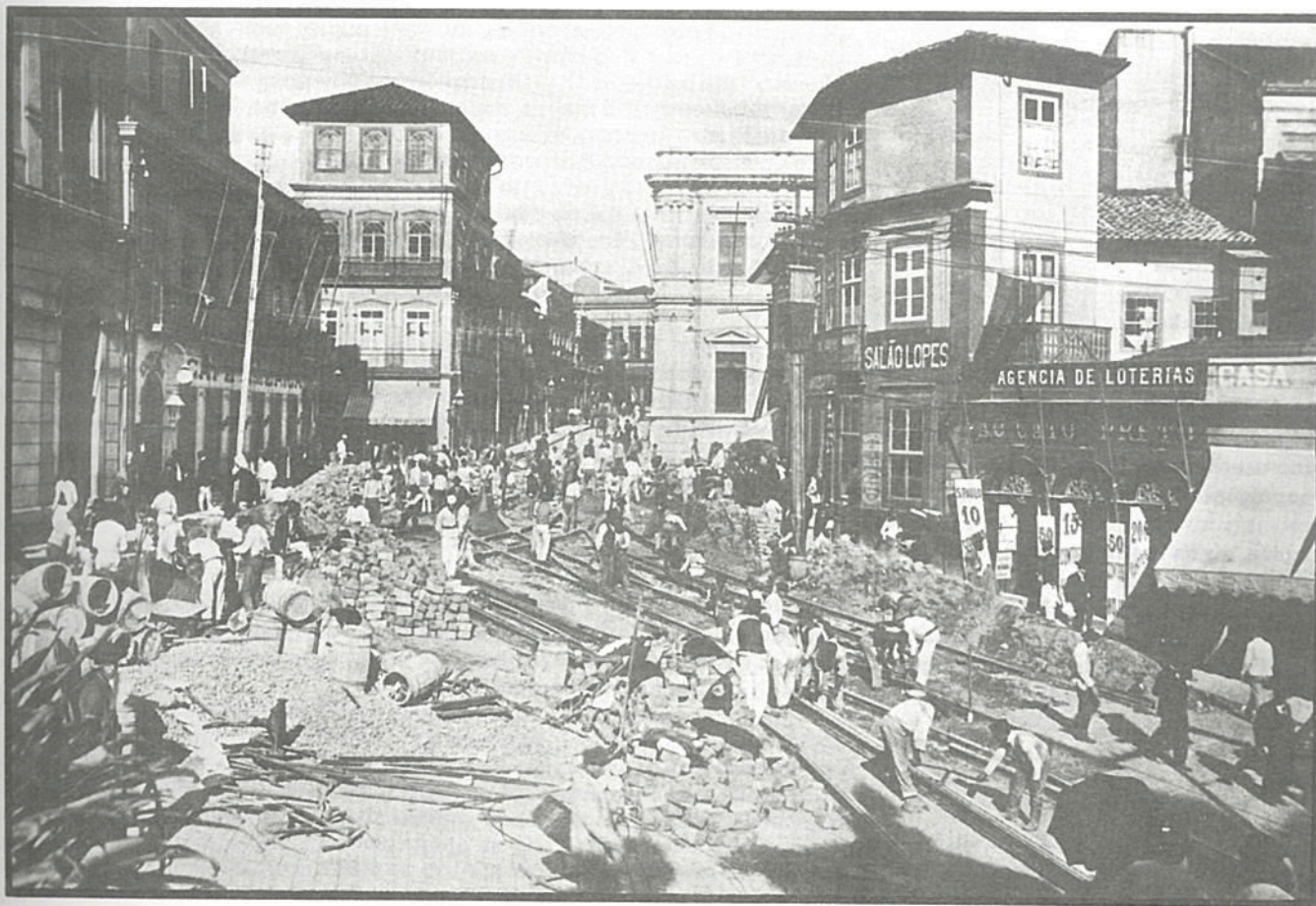
Instalação de trilhos no Largo do Tesouro, 24/3/1902
