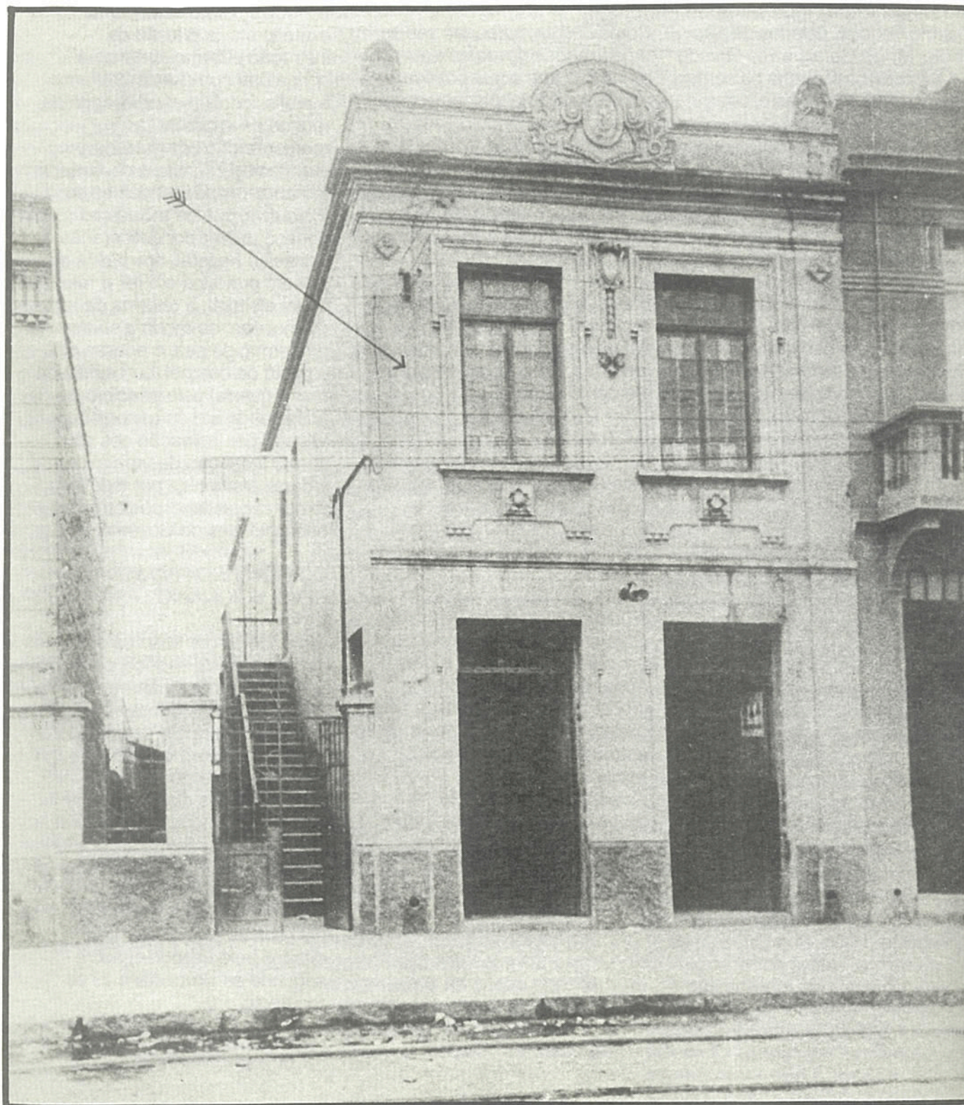
Sobrado da rua Vauthier no bairro da Luz, onde foi planejado o levante
