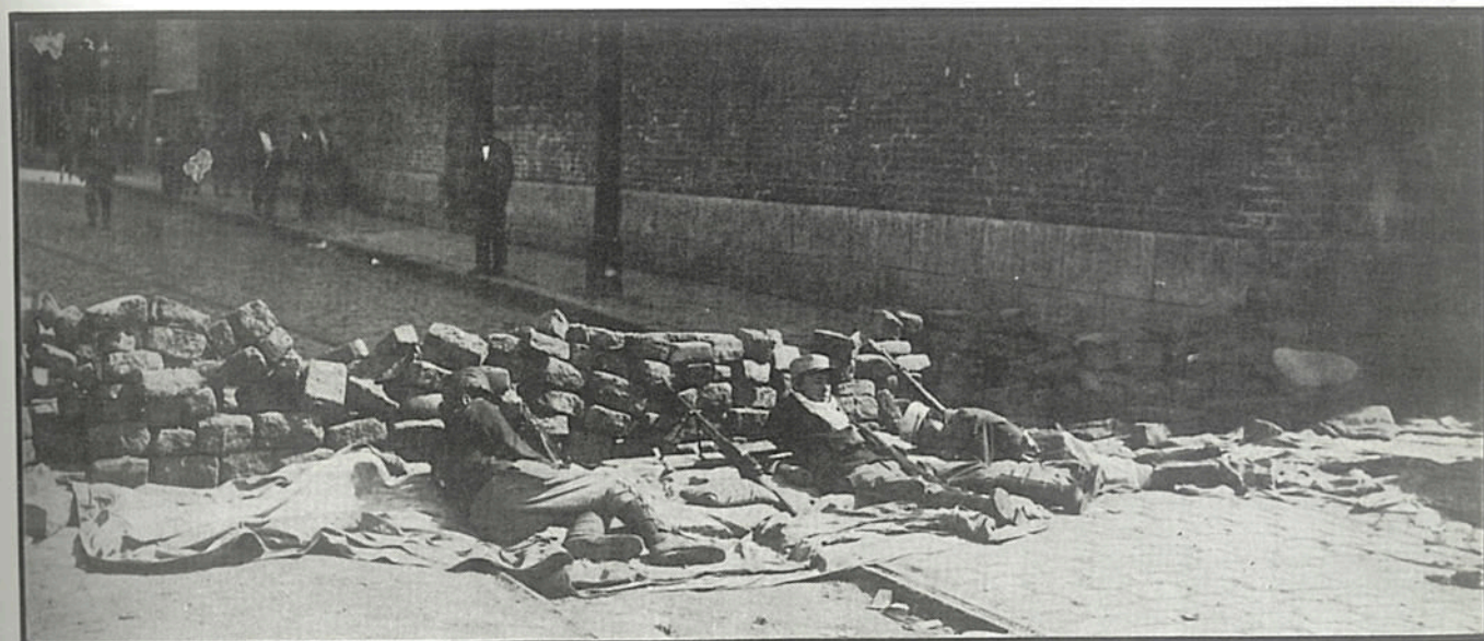
Trincheira revoltosa em frente à estação da Sorocabana
