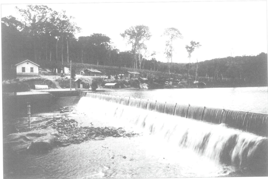
Barragem da usina Quilombo, s.d.
