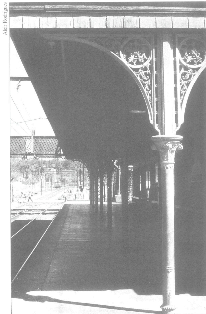
Detalhe da coluna de ferro da Estação, anos 70
