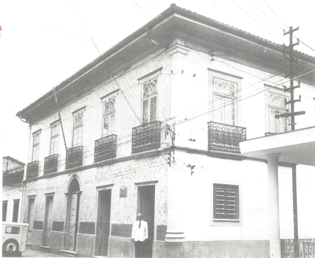
A agência de Itu, o poste da entrada lateral e detalhe da fachada principal: época de "tia" Inácia
