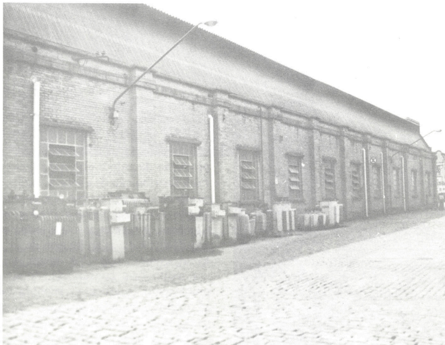
Transformadores no Cambuci, em 1988
