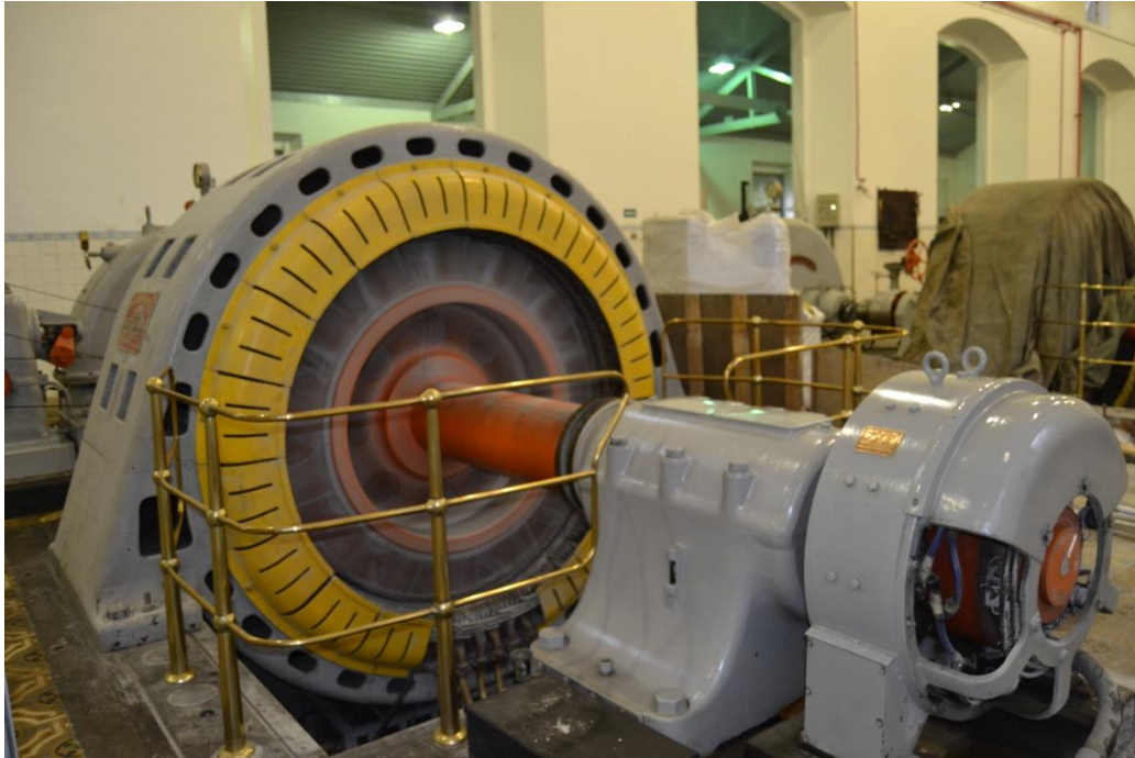
Itatinga: gerador GE original. Autor: Gildo Magalhães, 5/7/13
