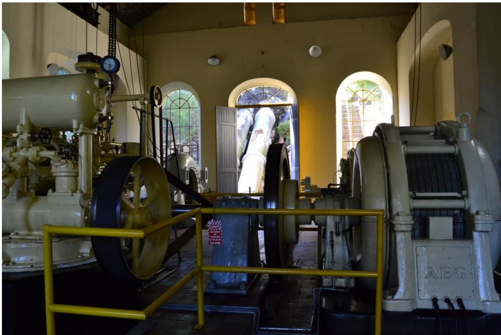
Salesópolis: turbina e gerador. Autor: Gildo, 4/7/13
