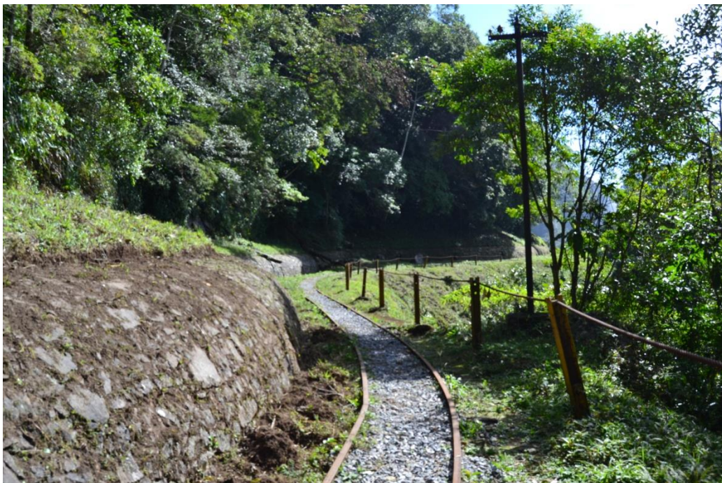
Itatinga: túnel de pedra para adução e via férrea de manutenção. Autor: Gildo, 5/7/13
