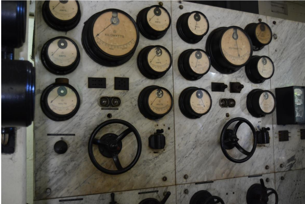
Salesópolis: quadro de comando original. Autor: Gildo Magalhães, 4/7/13
