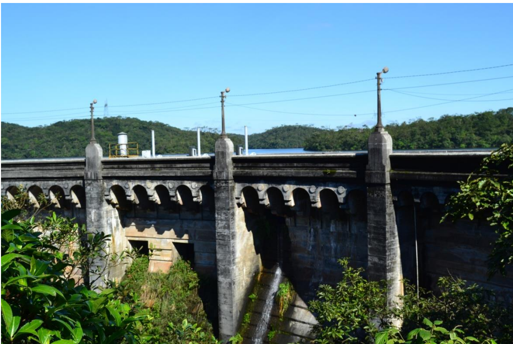
Billings: vertedouro e barragem de Rio das Pedras. Autor: Gildo, 3/7/13
