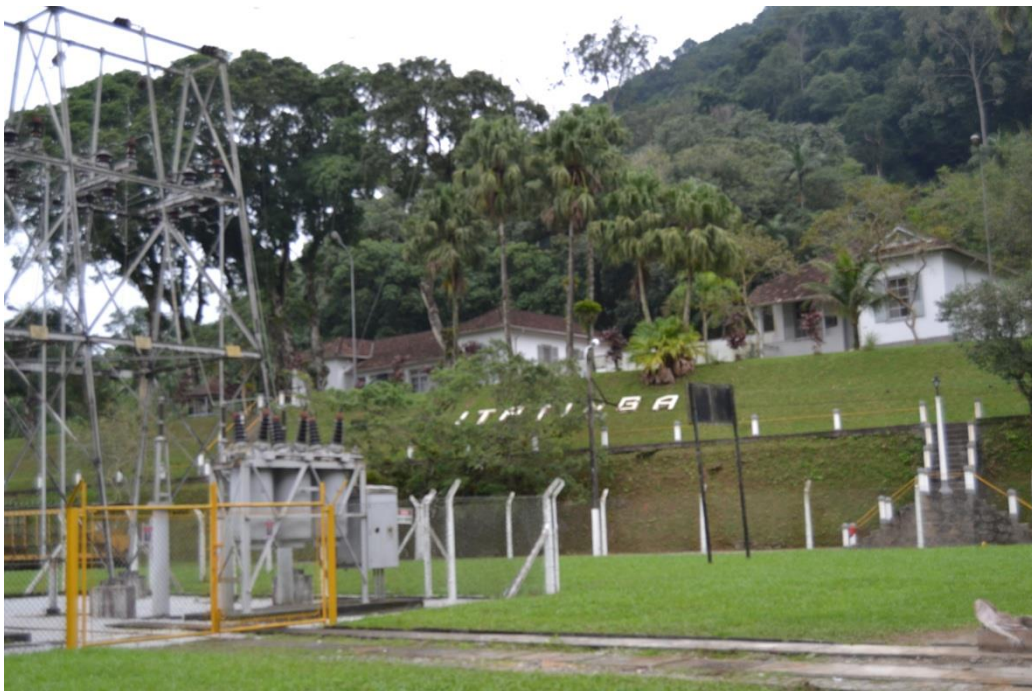
Itatinga: início da linha de transmissão em 44 kV. Autor: Gildo, 5/7/13
