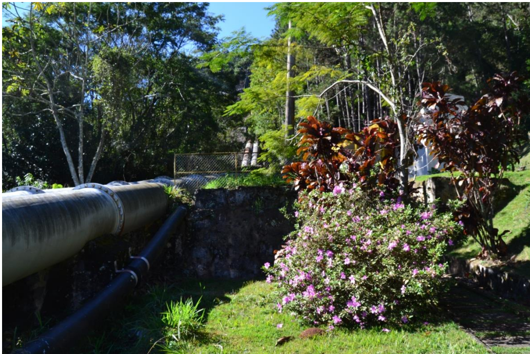
Salesópolis: tubulação de adução. Autor: Gildo Magalhães, 4/7/13
