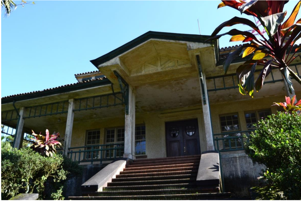
Billings: fachada frontal da Casa de Visitas, no alto da Serra. Autor: Gildo, 3/7/13
