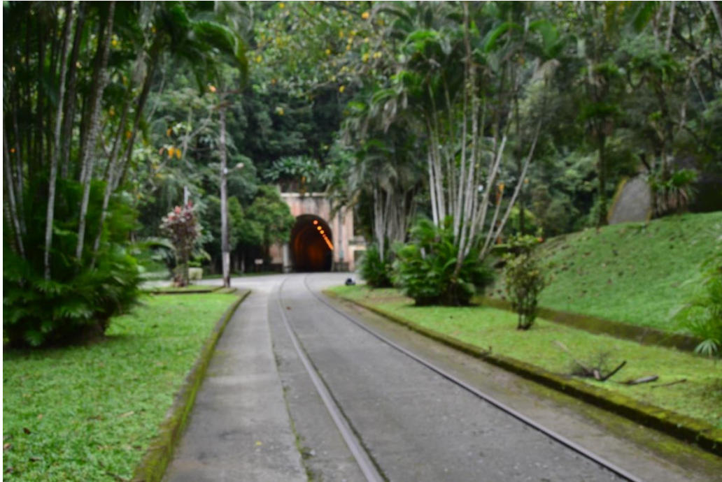
H. Borden: entrada do túnel da usina subterrânea. Autor: Gildo, 3/7/13
