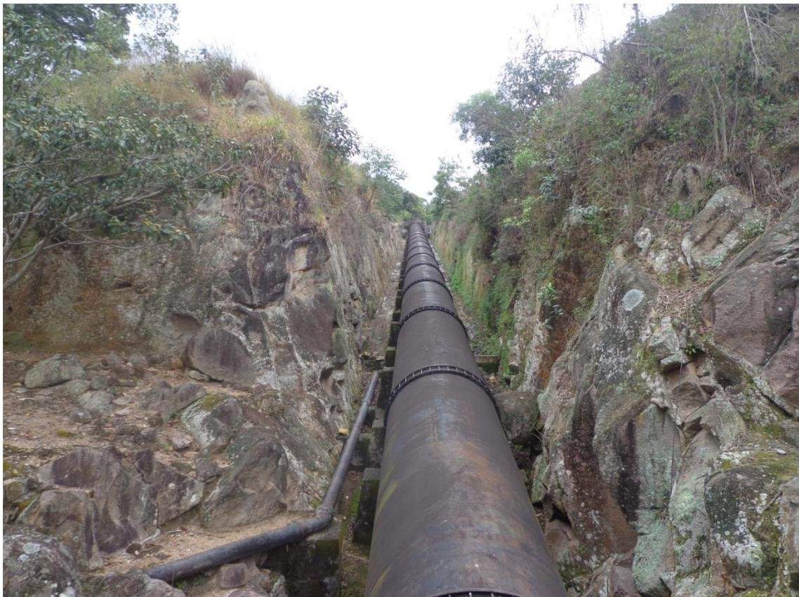
**Figura 12:** Tubo de adução instalado em meio à rocha. **Foto:** Olívia Campos **Data:** 02/07/2015
