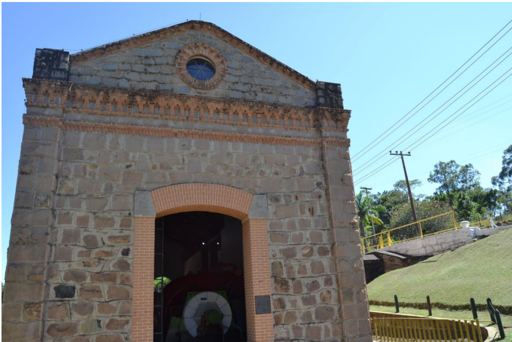
Salto Grande. Detalhe da fachada da usina. Foto: G. Magalhães, 21/1/2014
