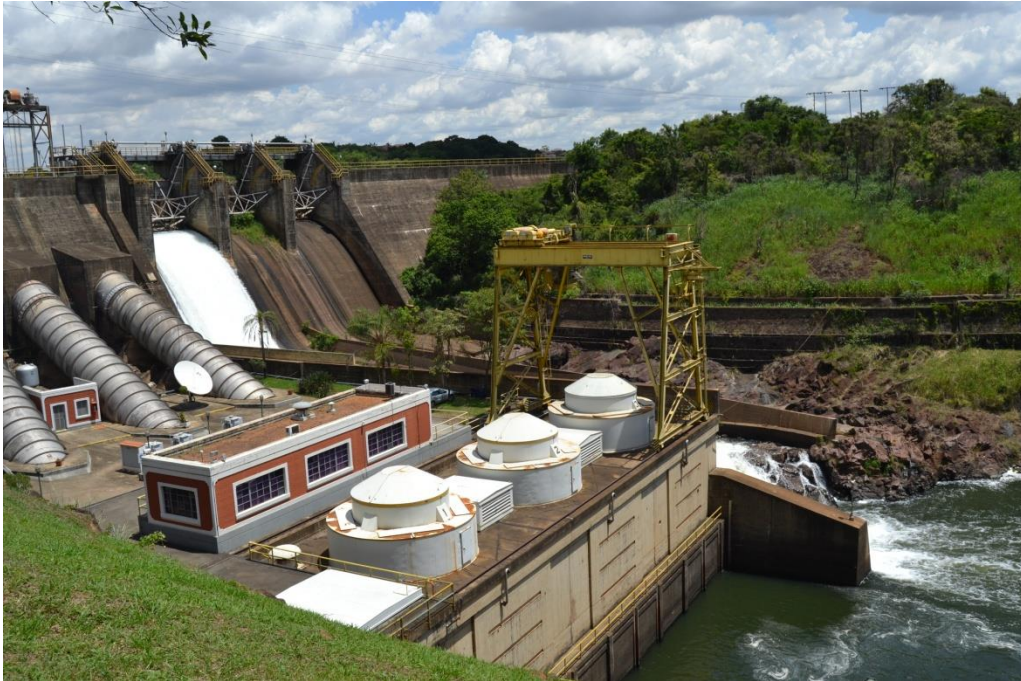
Americana. Barragem vista a jusante e usina; ao fundo, antigo canal de Salto Grande. Foto: G. Magalhães 22/1/2014
