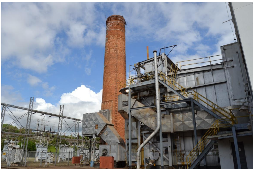
Carioba. Vista da usina termelétrica. Foto: Gildo Magalhães 22/1/2014
