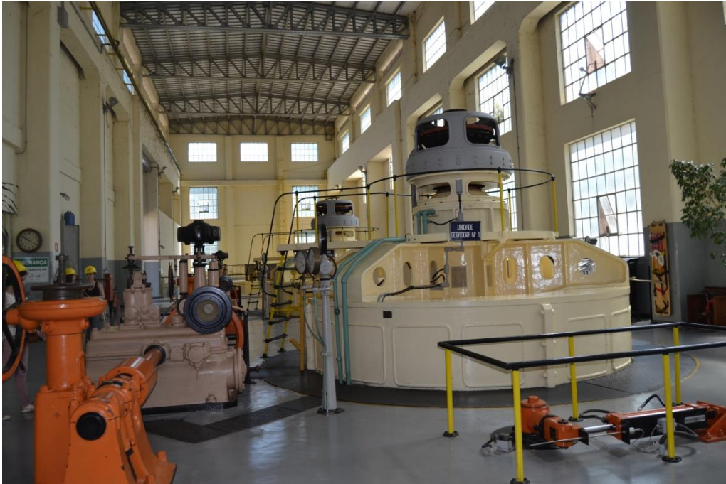
Porto Goes - Sala de máquinas com geradores (1938); à esquerda, regulador de velocidade. Autor: G. Magalhães, 20/1/2014
