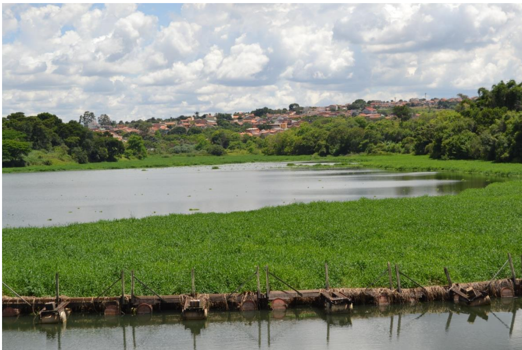
Americana. Represa e cerca de contenção de lixo e aguapés. Foto: G. Magalhães, 22/1/2014
