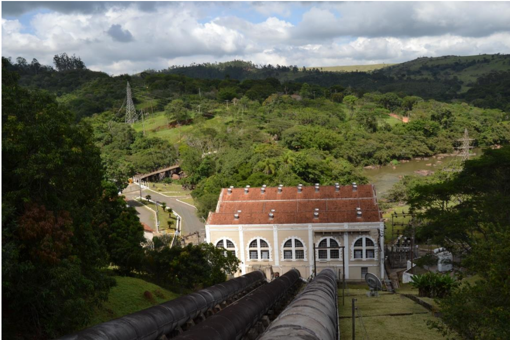
Jaguari. Tubulação de adução e usina. Foto: Gildo Magalhães 23/1/2014
