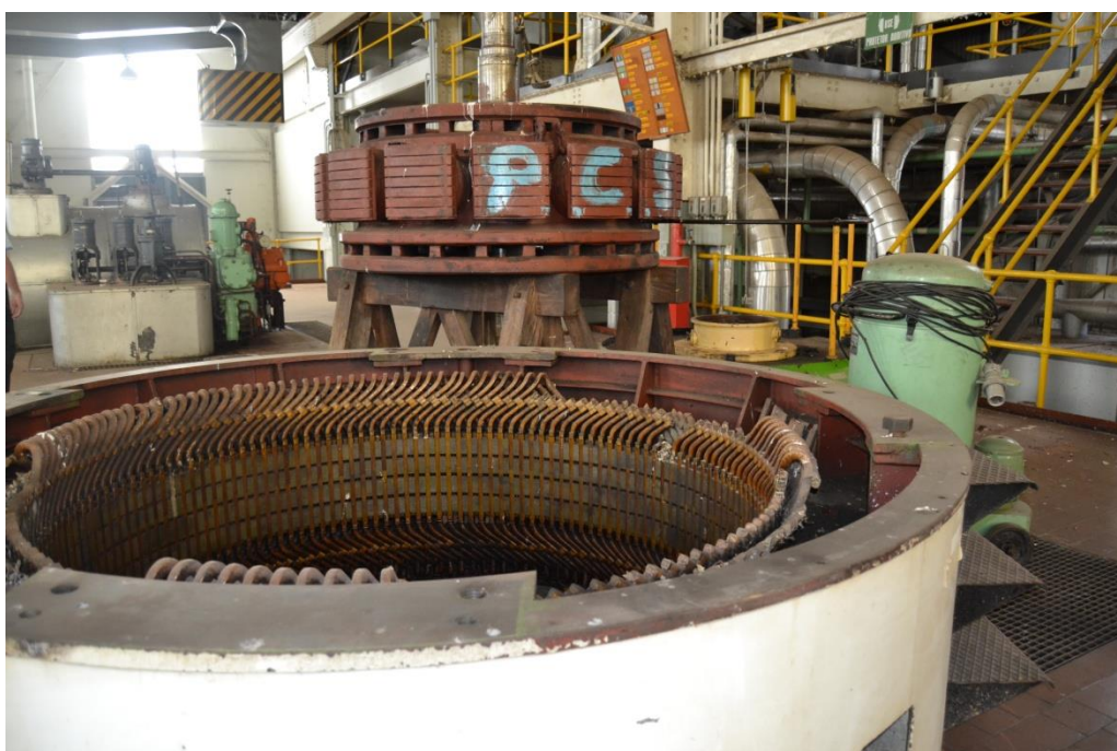
Carioba Gerador de Cariobinha armazenado na térmica. Foto: G. Magalhães, 22/2/2024
