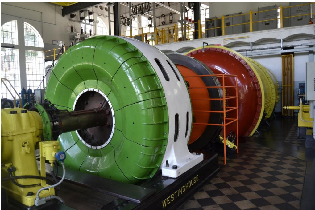
Jaguari. Interior da Casa de Força, gerador nº 1 (Westinghouse, 1919). Foto: G. Magalhães 23/1/2014
