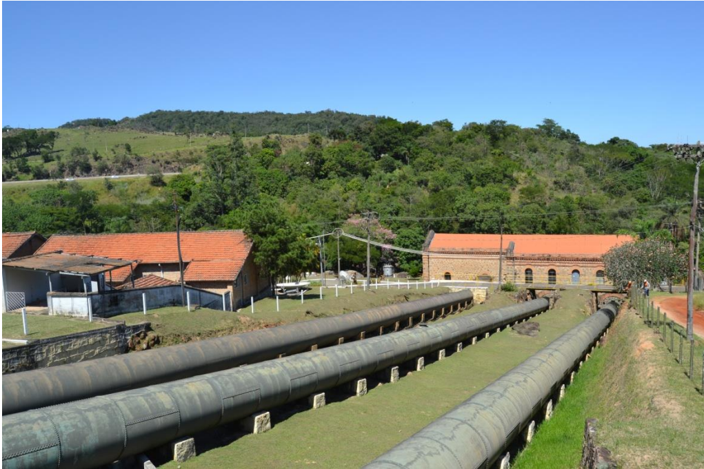
Salto Grande. Tubos de adução e usina; à esquerda casas da vila; ao fundo, rodovia D. Pedro; Foto: G. Magalhães, 21/1/2014
