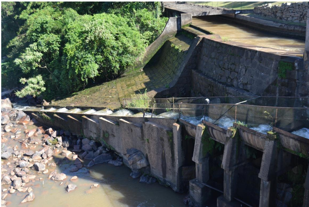
Salto Grande. Escada para subida de peixes do rio Atibaia para o reservatório. Foto: G. Magalhães 21/1/2014
