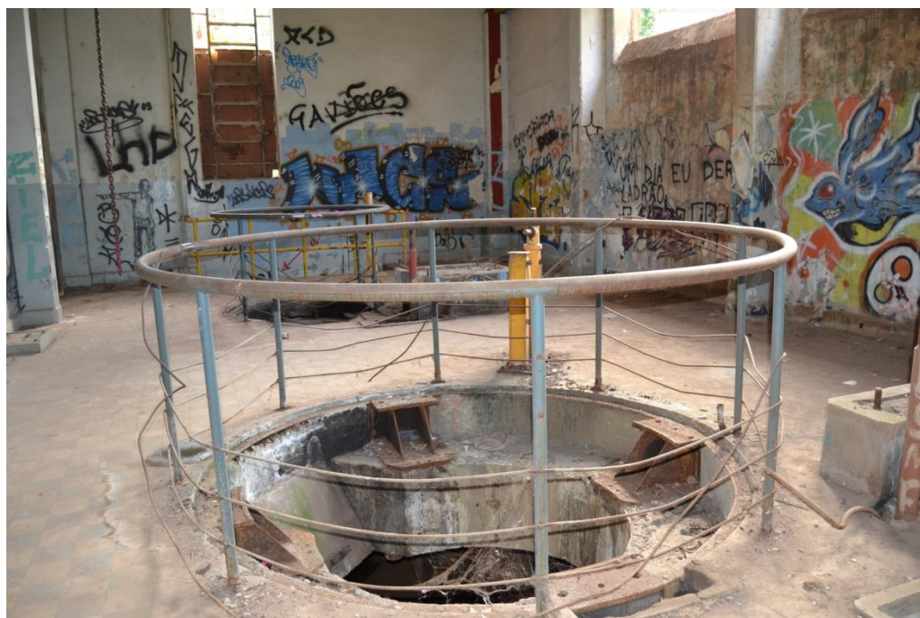
Cariobinha. Interior da Casa de Força, com poços abandonados das turbinas. Foto: G. Magalhães, 22/1/2014
