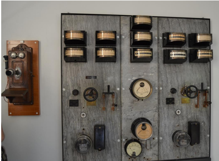
Salto Grande. Antigo painel de instrumentos elétricos e telefone a manivela. Foto: G. Magalhães, 21/1/2014
