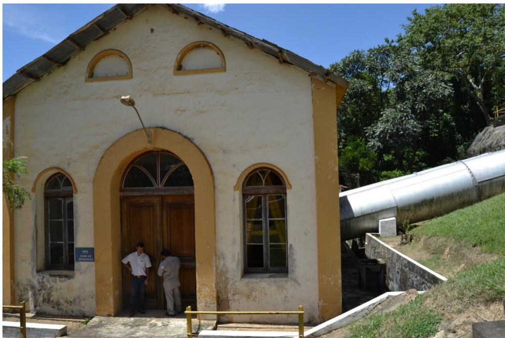
Salto de Pinhal. Fachada de entrada da usina e tubos de adução. Foto: G. Magalhães, 4/2/2014
