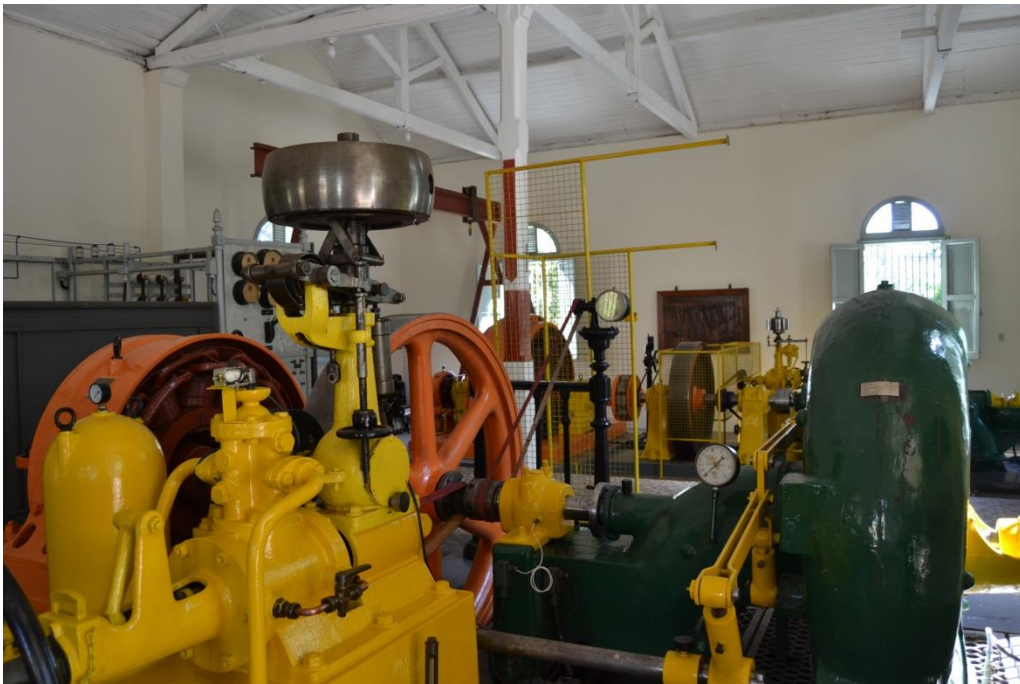
Santa Alice. Casa de máquinas 1 e 2 (1907) e 3 (1913). Foto: Gildo Magalhães 5/2/2014
