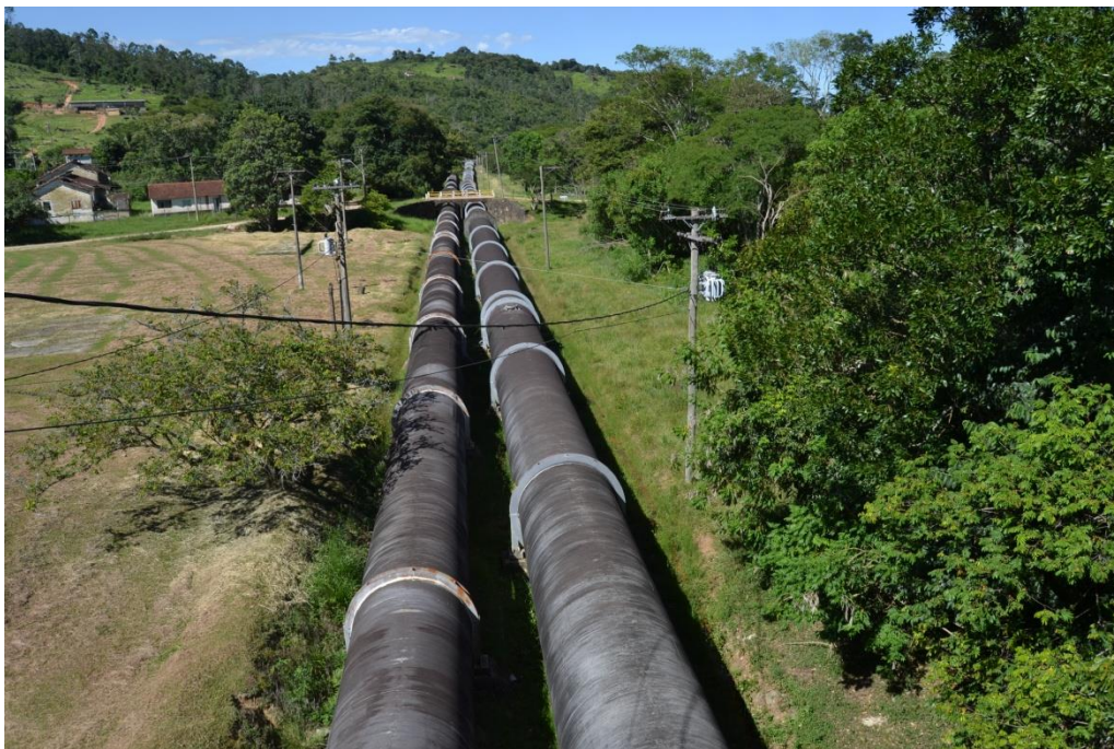
Eloy Chaves. Tubos de adução; ao fundo, casas da vila residencial. Foto: G. Magalhães, 4/2/2014
