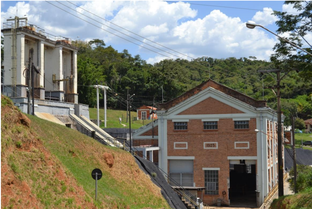
Rasgão. Vista da usina e dos dutos de adução. Foto: Gildo Magalhães 6/2/2014
