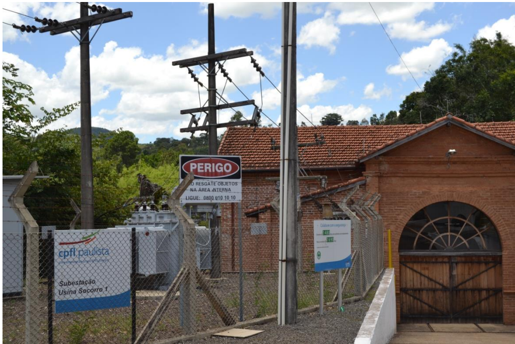
Socorro. Entrada da usina e subestação. Foto: Gildo Magalhães 3/2/2014
