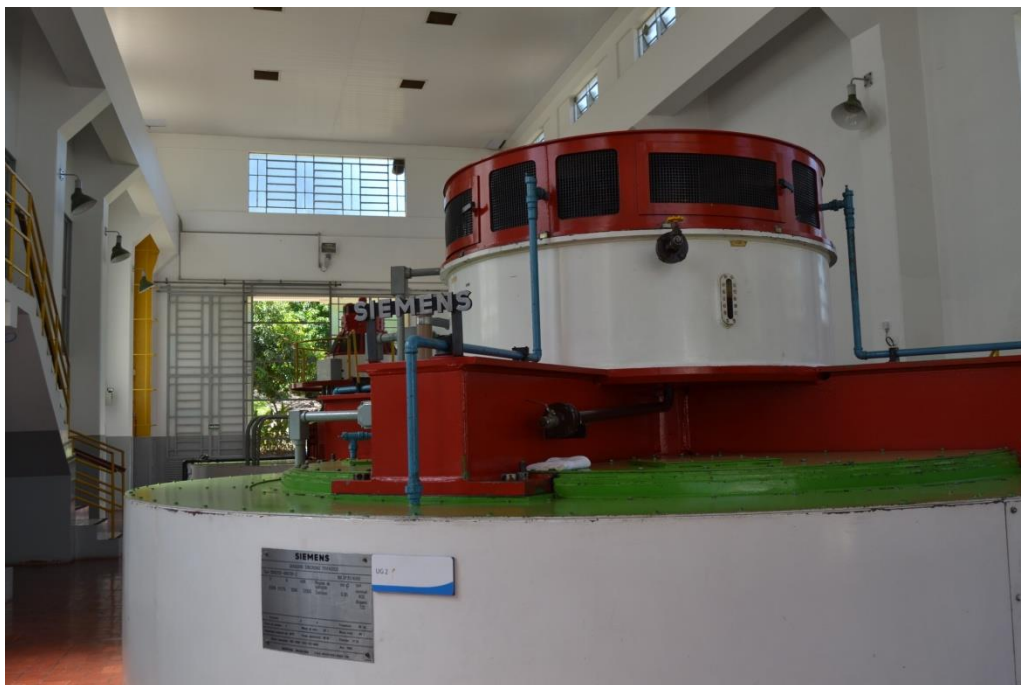
Eloy Chaves. Casa de Força, gerador Allis Chalmers (1954) repotenciado pela Siemens (1992). Foto: G. Magalhães 4/2/2014
