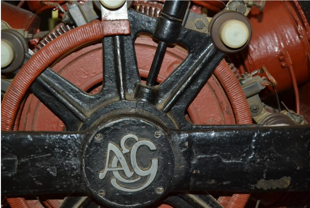
Salto de Pinhal. Detalhe do gerador 1 com logotipo AEG em “art nouveau” (1911). Foto: G. Magalhães 4/2/2014
