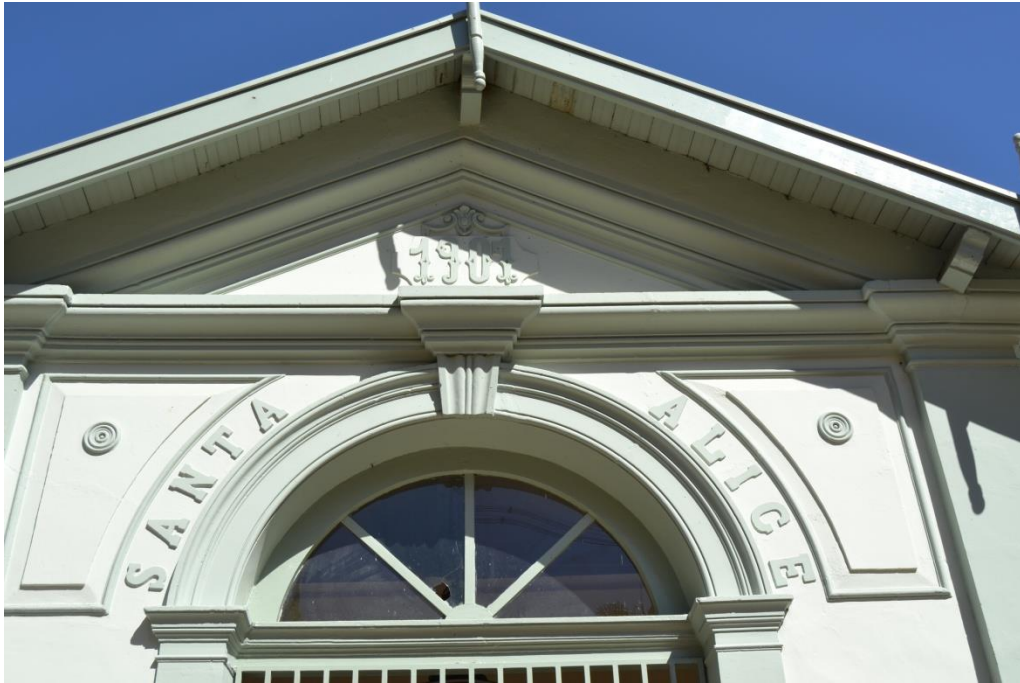
Santa Alice. Fachada de entrada (1907). Foto: Gildo Magalhães 5/2/2014
