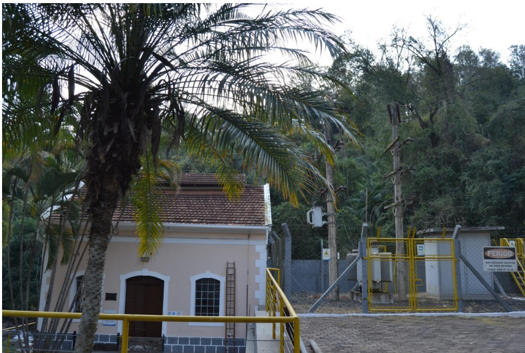
Monjolinho . Casa de força “nova” (1909) e subestação. Foto: G. Magalhães, 22/ 7/14
