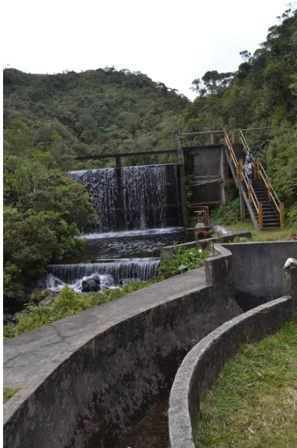
Isabel. Barragem inferior, comporta e canal de adução (seco). Foto: G. Magalhães, 24/7/14
