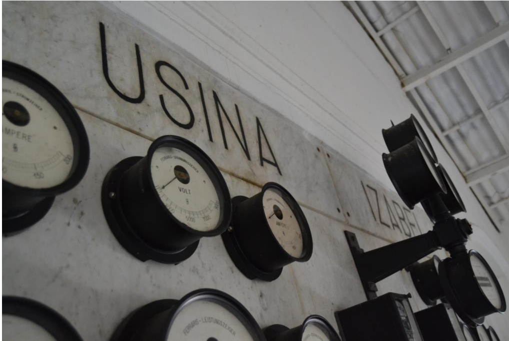
Isabel. Detalhe do painel de controle em mármore com instrumentação. Foto: G. M., 24/7/14
