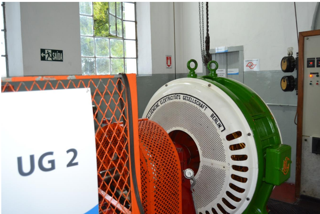
Monjolinho. Gerador 2, AEG (Alemanha). Foto: Gildo Magalhães, 22/7/14
