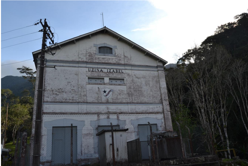
Isabel. Fachada da usina e transformador da subestação. Foto: G. Magalhães, 24/7/14
