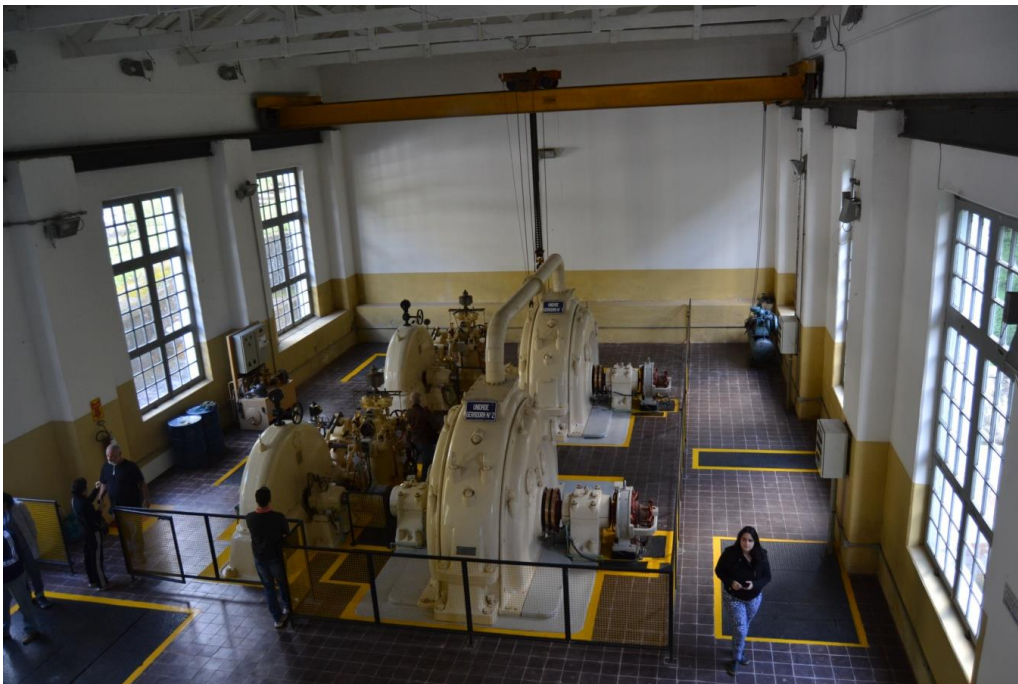
Isabel. Vista da sala de máquinas da casa de força. Foto: G. Magalhães, 24/7/14
