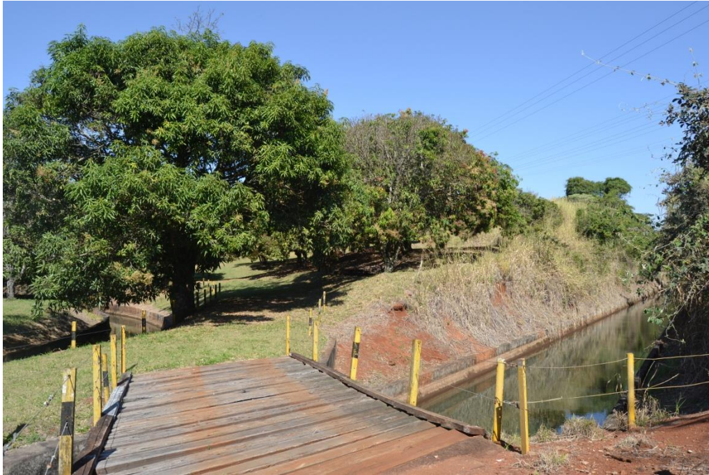
Capão Preto. Junção dos canais das barragens 29 e Alegria (esq.), e Retiro e Alegria (dir.), para formar a câmara de carga. Foto: G. Magalhães, 22/7/14
