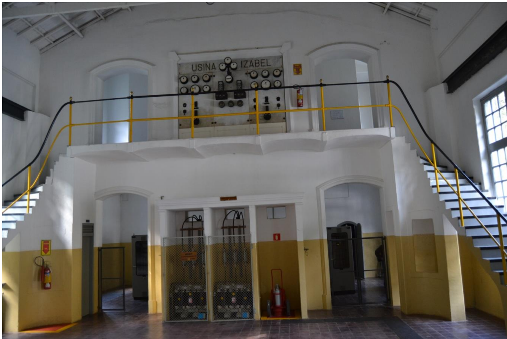
Isabel. Mezanino da sala de máquinas, com painel de instrumentos. Foto: G. Magalhães, 24/7/14
