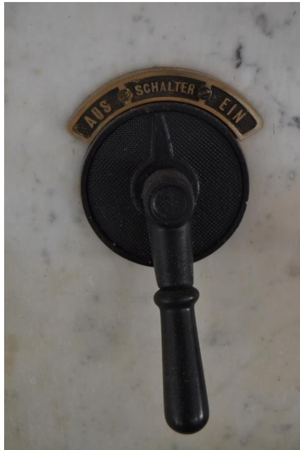
Isabel. Detalhe do painel, chave de acionamento. Foto: Gildo Magalhães, 24/7/14
