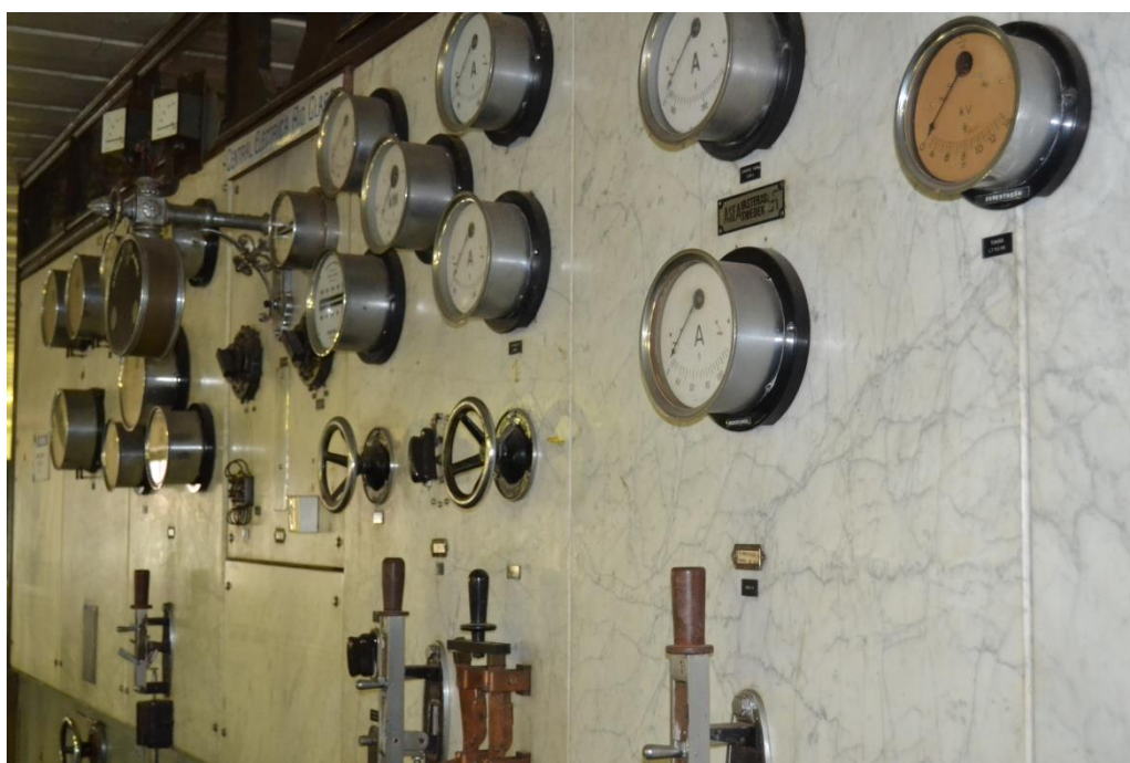
Corumbataí. Painel em mármore com instrumentos e comandos do início do séc. 20. Foto: G. Magalhães, 21/7/14
