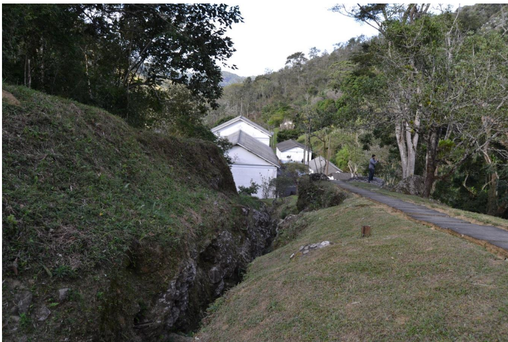
Isabel. Vista da usina e oficinas no início da trilha da tubulação. Foto: G. Magalhães, 24/7/14
