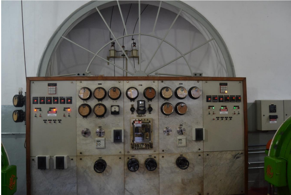
Monjolinho. Interior da casa de força, painel de controle original (1909) de mármore em uso; ao fundo, barramento de saída. Foto: G. Magalhães, 22/7/14
