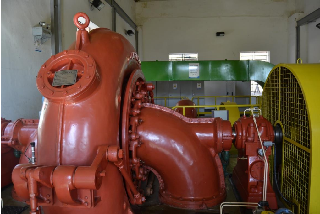
Capão Preto. Vista da sala de máquinas, turbina e gerador nº 2. Foto: G. Magalhães, 22/7/14
