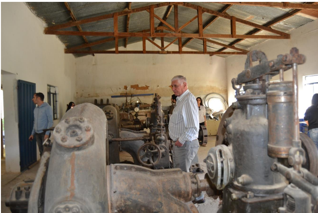
Lia-Marmelos 2. Turbinas e geradores abandonados na casa de força. Foto: G. Magalhães, 23/7/14
