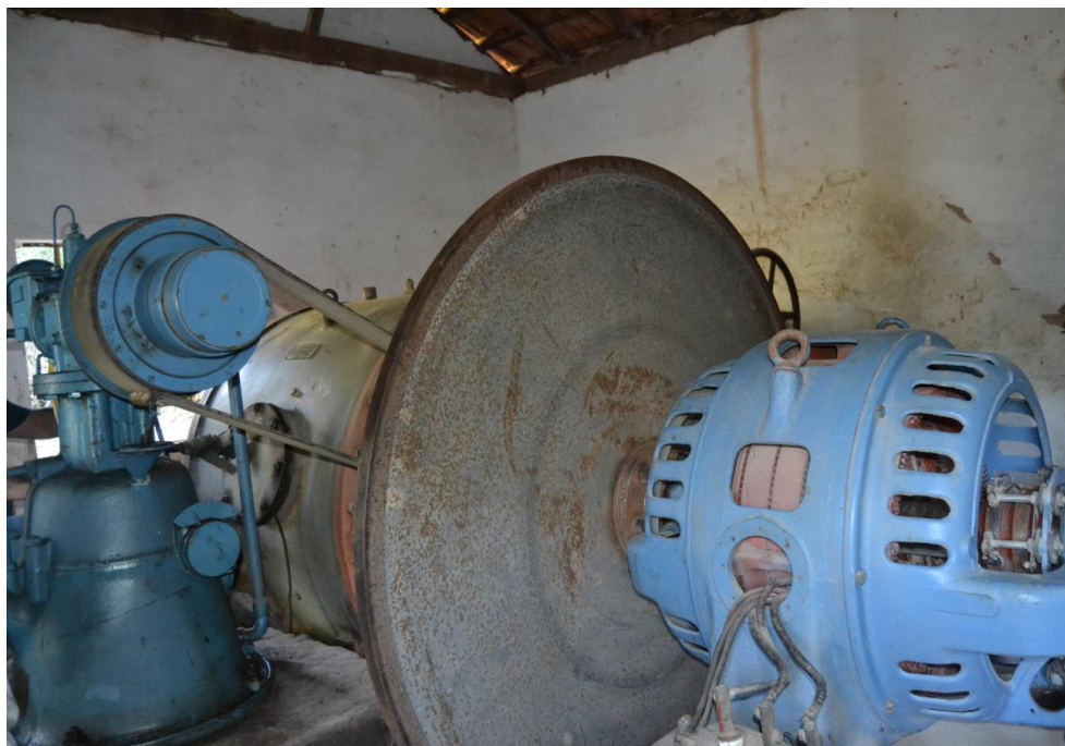
Lia-Marmelos I. Equipamentos abandonados na casa de força. Foto: G. Magalhães, 23/7/14
