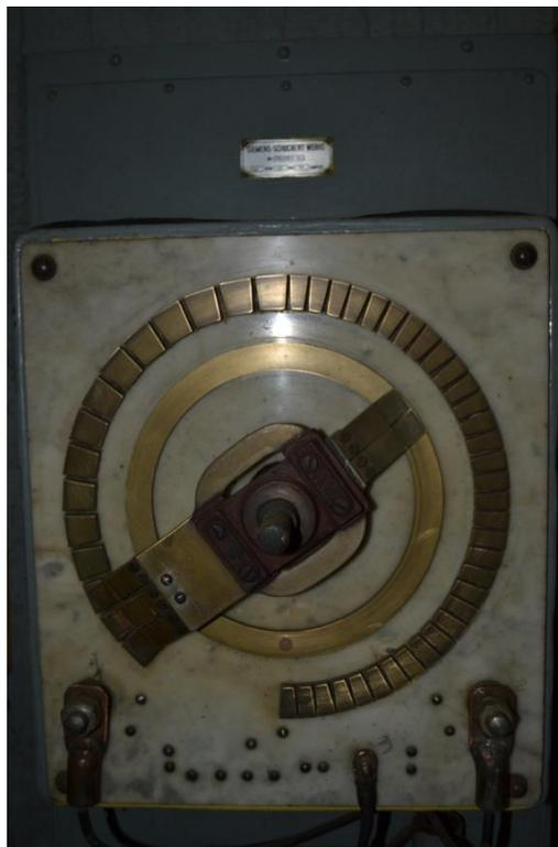
*Três Saltos.* Traseira do ajuste fino (manual) do gerador Siemens-Schuckert. Foto GM 8/1/15
