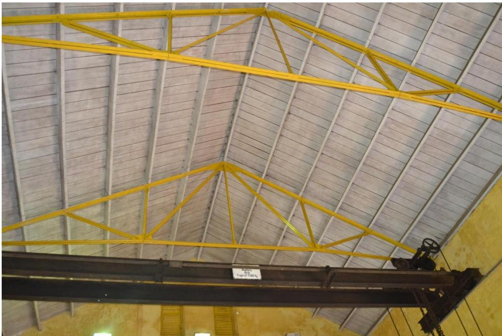
*S. Valentim.* Detalhe de forro e tesouras do telhado, com ponte rolante original (Alemanha, 1910).
