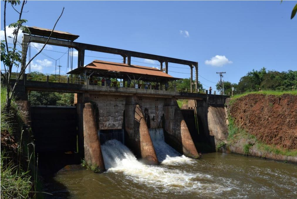
*Santana.* Barragem, comportas e vertedouro da barragem no rio Jacaré-Guaçu. Foto GM 9/1/2015
