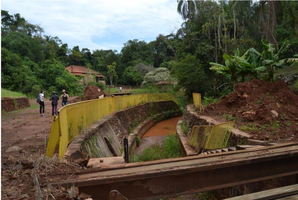
*Jacaré.* Canal de fuga após enxurrada causada pelo rompimento da tubulação. Foto GM 7/1/2015
