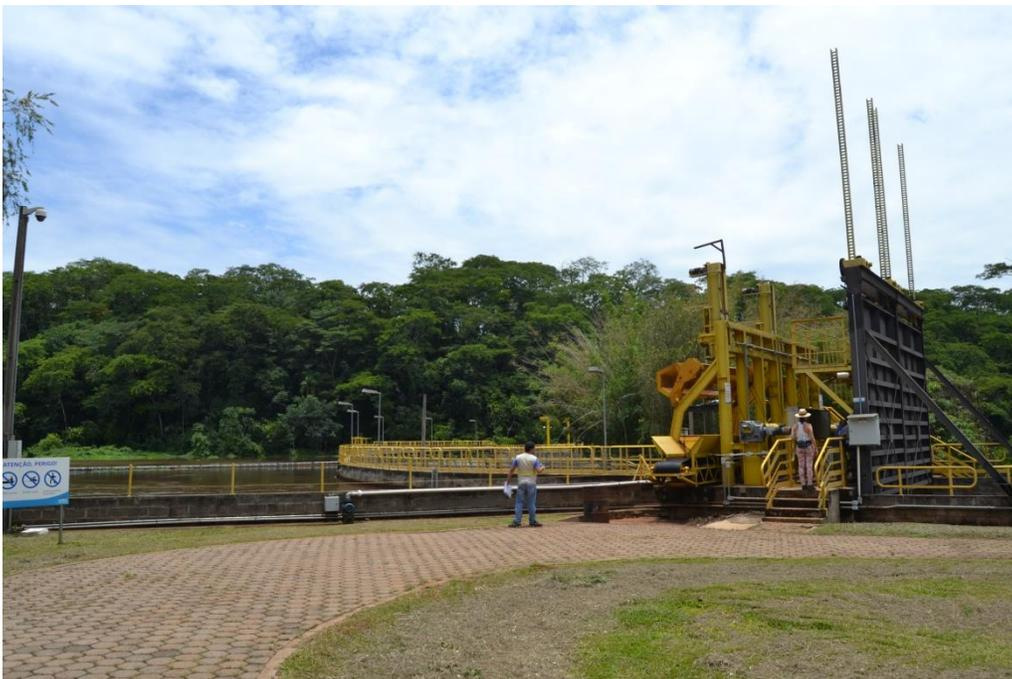
*Gavião Peixoto.* Barragem em arco e limpa-grade da câmara de carga. Foto GM 6/1/2015
