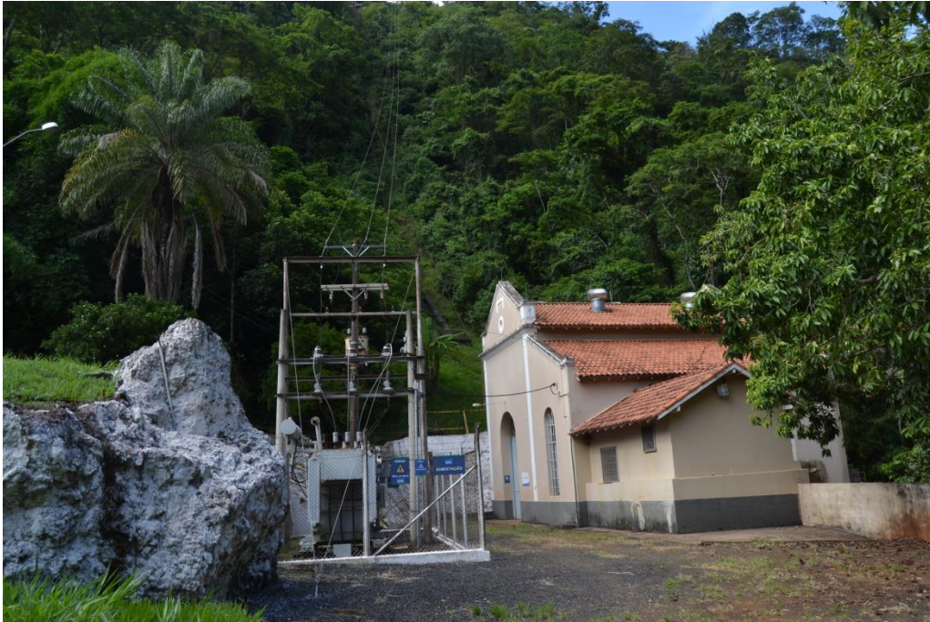
Buritis. Subestação e casa de força. Foto Gildo Magalhães 24/2/2015
