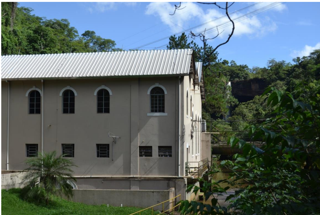
Esmeril. Casa de força, com seção final aérea da tubulação e, ao fundo, a cachoeira. Foto GM 25/2/15
