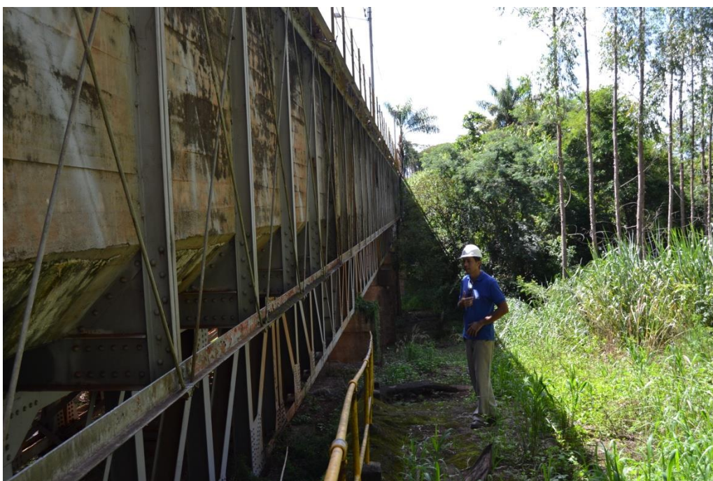
Dourados. Detalhe da estrutura da ponte metálica sob o canal de adução e passagem para veículos. Foto GM 25/2/15
