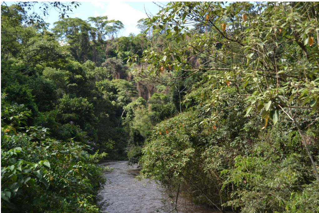
Esmeril. Canal de fuga. Foto Gildo Magalhães 25/2/2015
