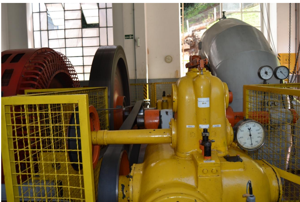
Lobo. Interior da casa de força: gerador, regulador, turbina. Foto G. Magalhães 23/2/15
