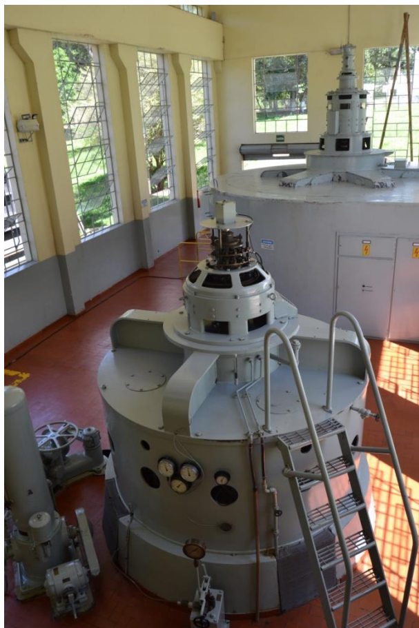
Itaiquara. Vista da sala de máquinas: à frente a primeira unidade. Foto GM 26/2/15
