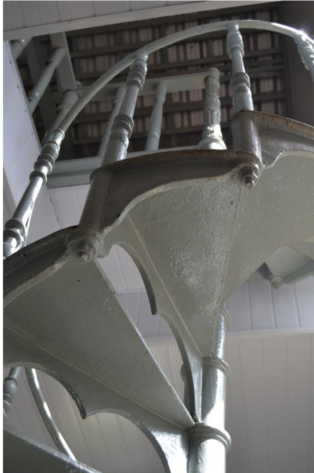
Esmeril. Detalhe da escada em caracol para o sótão da casa de força. Foto G.Magalhães 25/2/15
