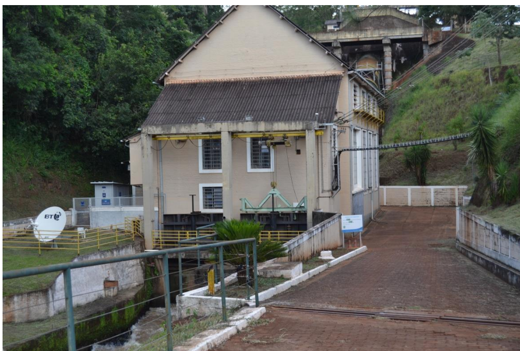
Dourados. Casa de força e canal de fuga; atrás, tubo de adução. Foto GM 25/2/15
