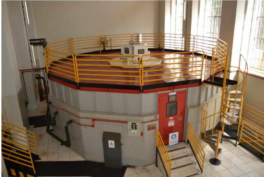
Dourados. Gerador. Foto Gildo Magalhães 25/2/2015
