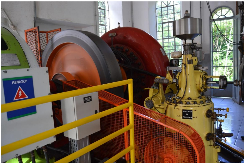
Buritis. Conjunto gerador, turbina e regulador de velocidade. Foto G. Magalhães 24/2/15
