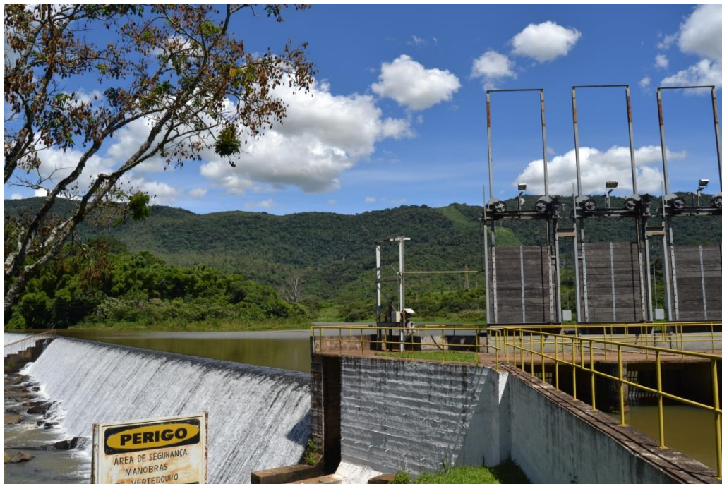
Itaiquara. Barragem, escada de peixe, comporta e início do canal de adução. Foto GM 26/2/15
