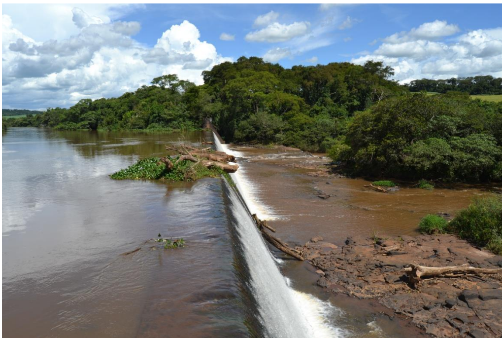
Dourados. Represa e vertedouro em soleira livre. Foto Gildo Magalhães 25/2/2015
