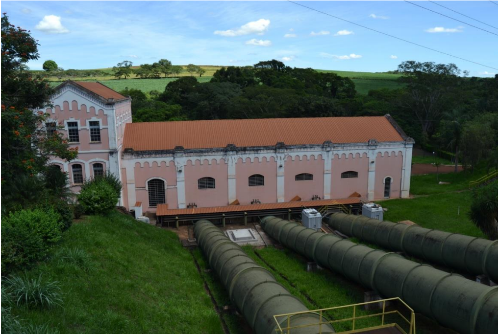
S. Joaquim. Tubulação de adução e edifício da casa de força. Foto G. Magalhães 24/2/15
