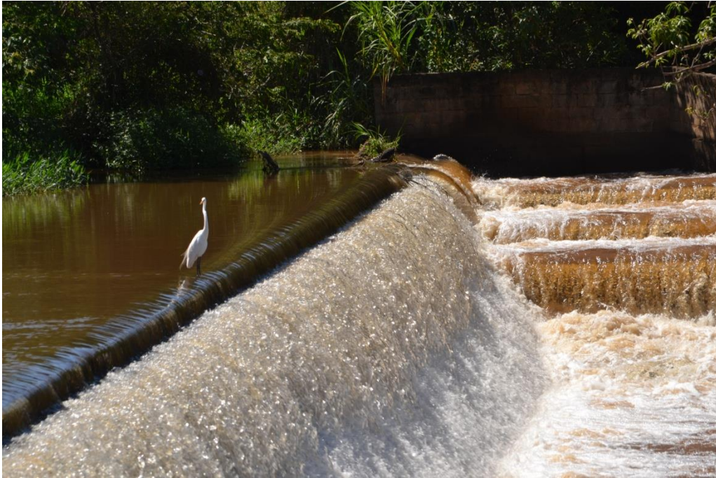
S. Joaquim. Vertedor livre na barragem, com garça; á direita, escada de peixe. Foto GM 24/2/15
