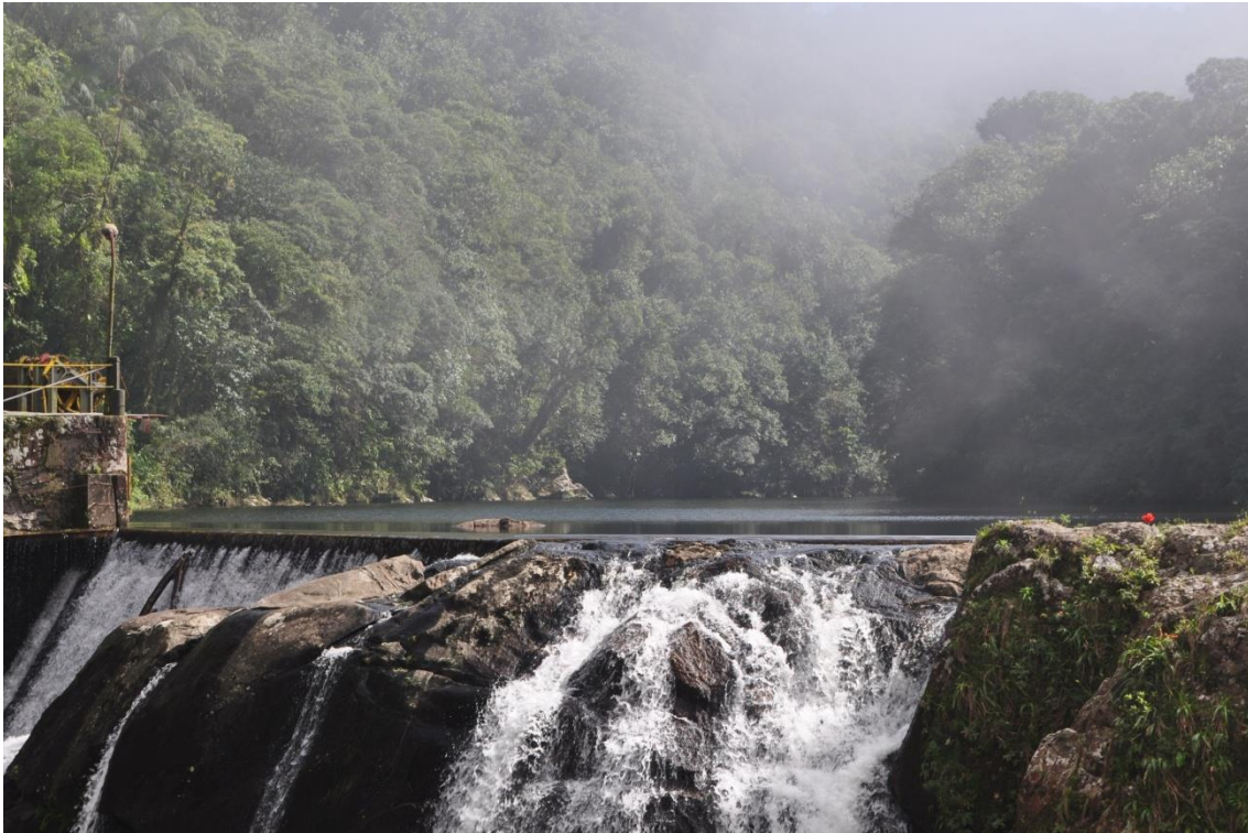
Figura09. Ponto 09. Barragem de Itatinga
