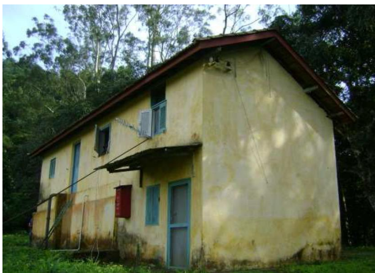
Casa 0. Fonte: Estudo ambiental para regularização do Porto de Santos, Agosto 2011.
