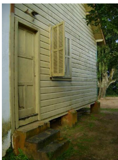
Alojamento. Estudo ambiental para regularização do Porto de Santos, Agosto 2011
