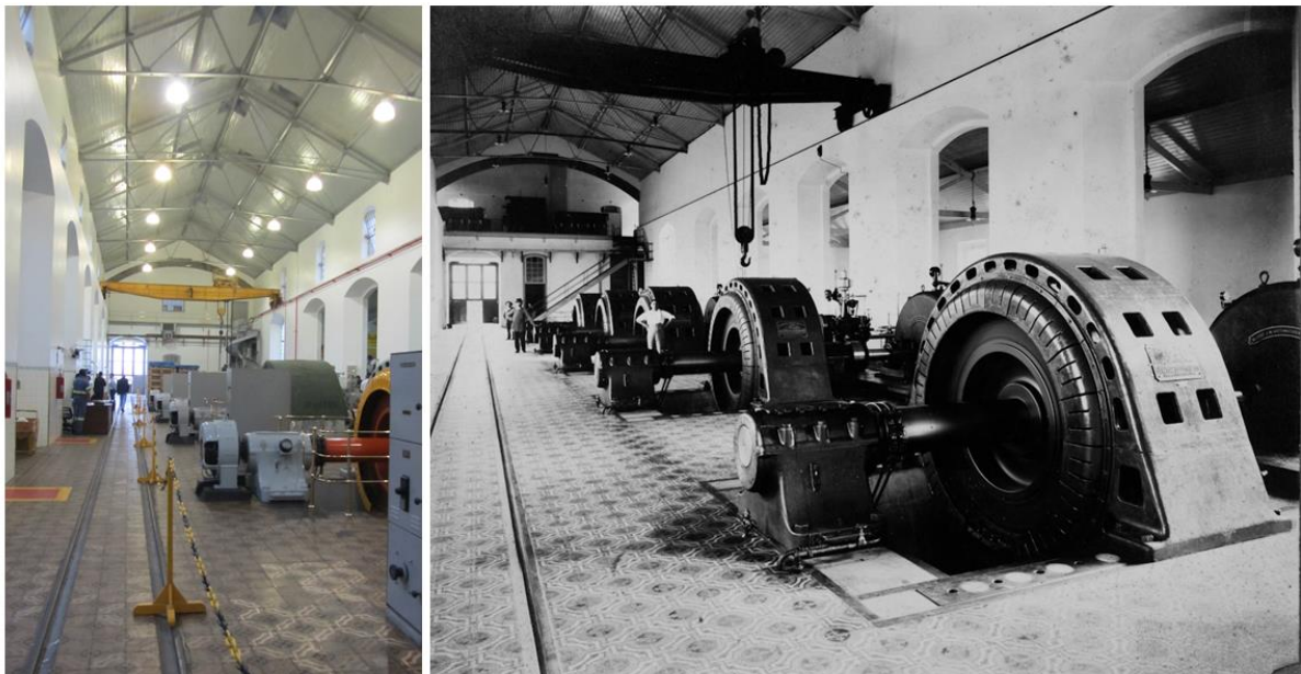
Figura 23. Casa de máquinas. Denise Geribello, 2013 e Acervo Docas S/A, s.d.
