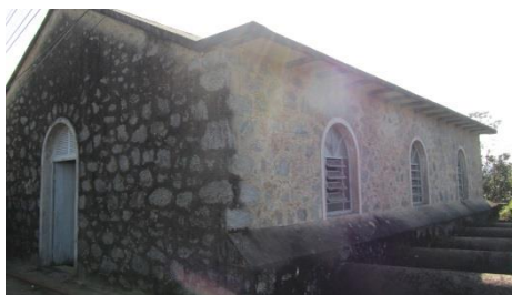
Foto: Casa das Válvulas de Momento, Denise Geribello, 9 Ago. 2012
