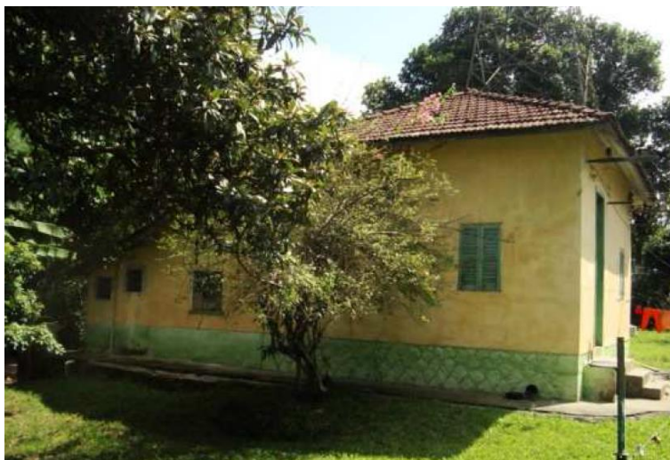
Casa do Feitor. Estudo ambiental para regularização do Porto de Santos, Agosto 2011.
