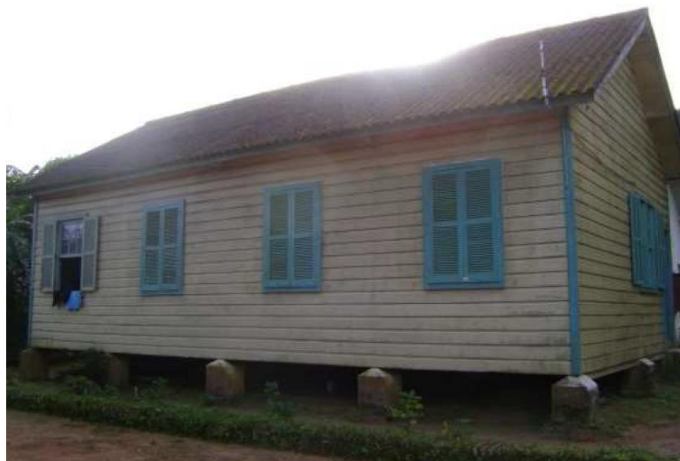
Casa do encarregado. Estudo ambiental para regularização do Porto de Santos, Agosto 2011
