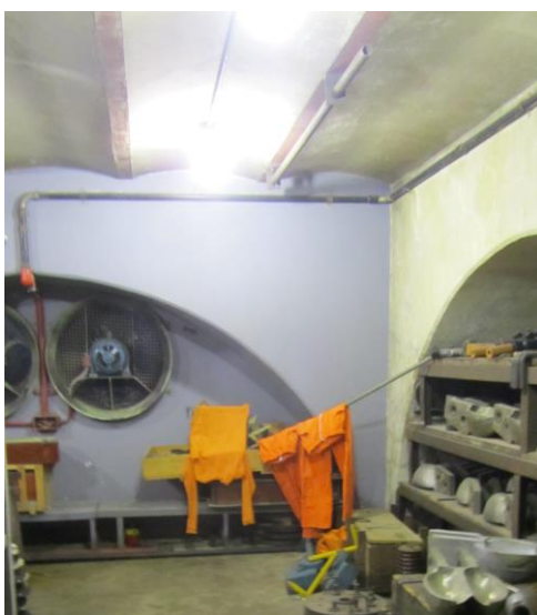
Galeria do subsolo. Nas laterais os arcos localizados sobre as pilastras de fundação e acima o sistema de abobadilhas entre vigas de ferro. Foto: Denise Geribello, 2013.
