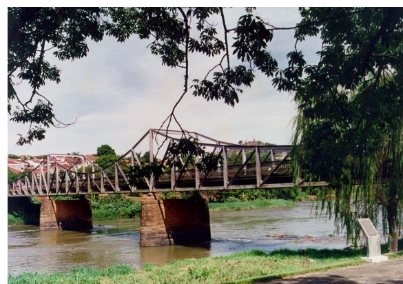
Figura 78. Ponte Metálica. Fonte: CONDEPHAAT-UPPH.
