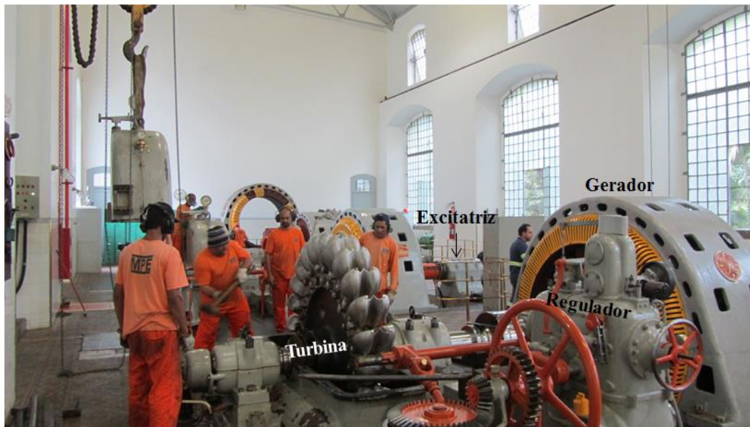
Figura 19. Manutenção da turbina. Denise Geribello, 2013.
