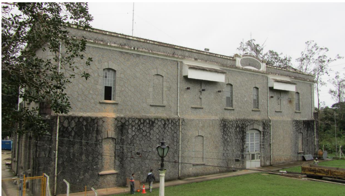
Figura 31. Fachada da Casa de Força, Denise Geribello, 2013.
