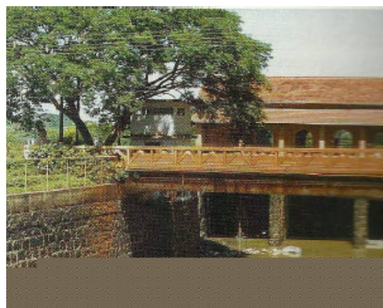
Figura 113. Fig. 113A. UHE Isabel, São José dos Campos. Fig. 113B. UHE Emas Velha; Pirassununga. Fonte: Amaral e Prado (2000).
