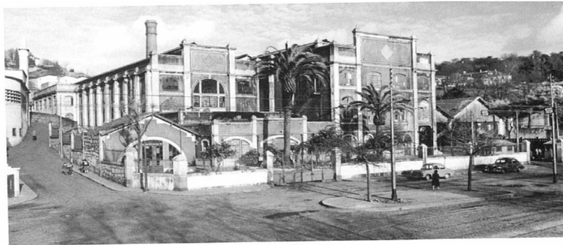
Figura 70. Central Térmica de Massarelos, Porto, Portugal. Fonte: MATOS, 2003
