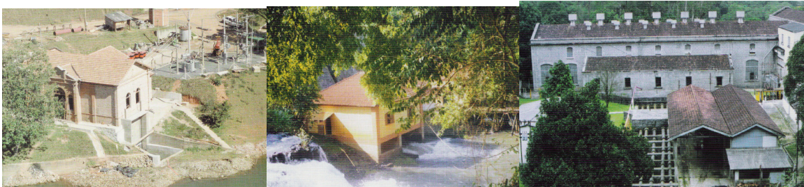
Figura 63. Fig. 63A. UHE Socorro, Socorro Fig. 63B. UHE Rio Novo, Avaré Fig. 63C. UHE Itatinga, Bertioiga. Fonte: AMARAL e PRADO (2000)
