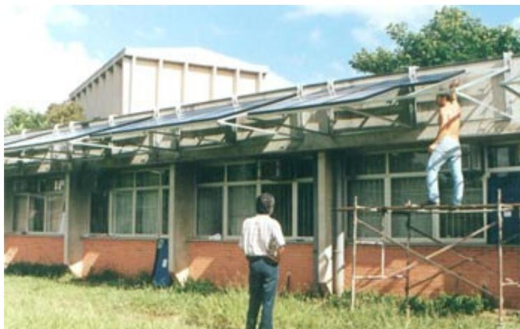
**Figura 12.** Fachada do prédio do IEE com os painéis fotovoltaicos montados (Fonte da imagem: PUREFA, USP)
